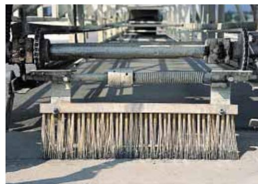
▲ Un broissage superficiel donne sa texture à la surface de roulement.
