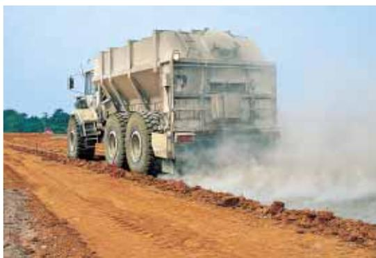
▲ La quantité de liant épandue sur le sable est dosée à raison de 5 % du poids du matériau à traiter, soit 40 kg. Deux phases sont nécessaires.
