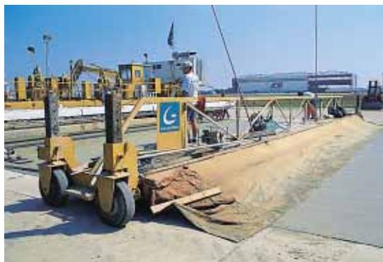
▲ Le passage d'une toile de jute humide unifie la surface de la dalle.
