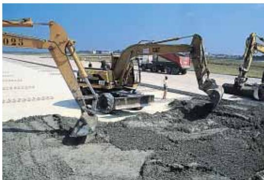
▲ Déversé par deux camions-bennes à la fois, le béton est réparti à l'aide de trois pelles hydrauliques.
