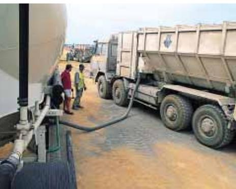
▲ Le liant hydraulique routier acheminé par citernes sur le chantier, est transféré dans la benne de l'épandeur au moyen d'une pompe.
