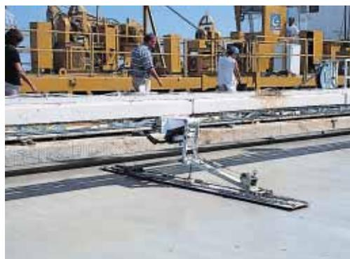
▲ Une grande taloche lisse la surface du béton à l'arrière de la slipform.
