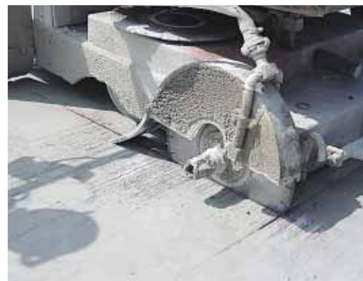
▲ Le sciage du revêtement béton s'effectue dans un premier temps sur 9 cm de profondeur.
