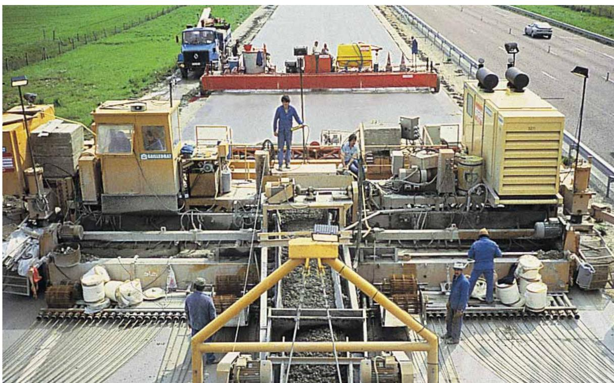
▲ Mise en œuvre d'un revêtement autoroutier en béton. À l'arrière-plan, atelier de traitement de surface.
