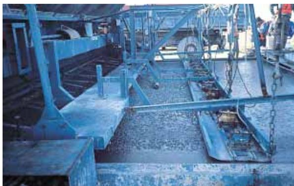
▲ Après réparation, enchâssement des "clous" à l'aide d'une lame vibrante.
