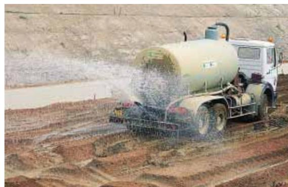
▲ Plusieurs corrections hygrométriques du matériau sont réalisées tout au long des phases de chantier pour obtenir une teneur en eau de 10 à 11 %.
