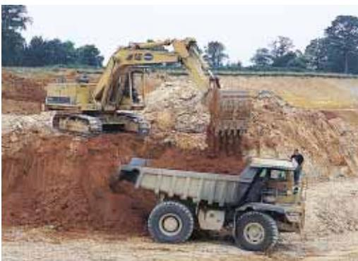
▲ Un gisement de sable du pliocène, déblai du chantier, a été mis à profit pour réaliser la plate-forme en raison de sa qualité.
