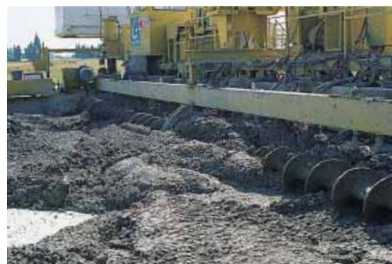
▲ Disposée à l'avant de la slipform, une double vis répartit le béton avant sa mise en place.
