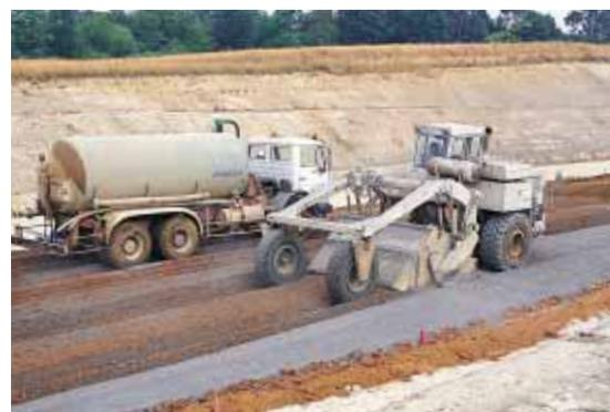
▲ Le passage du pulvimixeur (ou malaxeur) amène un mélange du sable préalablement humidifié et du liant hydraulique routier.
