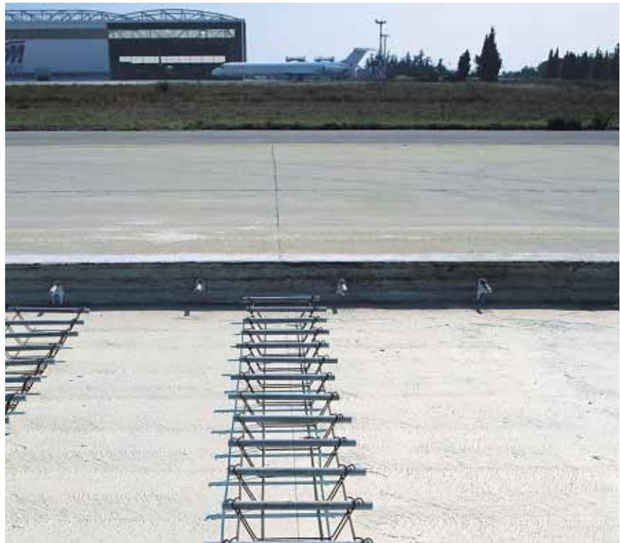
▲ Les joints du revêtement béton sont goujonnés. Les goujons, placés sur des paniers, sont positionnés dans le prolongement des joints de l'ancien revêtement.
