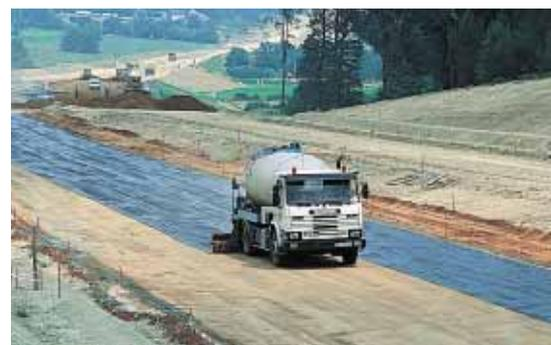
▲ La plate-forme est protégée par une émulsion gravillonnée qui offrira une surface propre et cicuable pour les équipes venant réaliser la chaussée.
