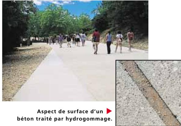
Aspect de surface d'un béton traité par hydrogommage.
