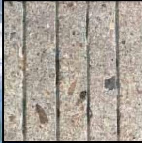
▲ Aspect de surface d'un béton rainuré.
