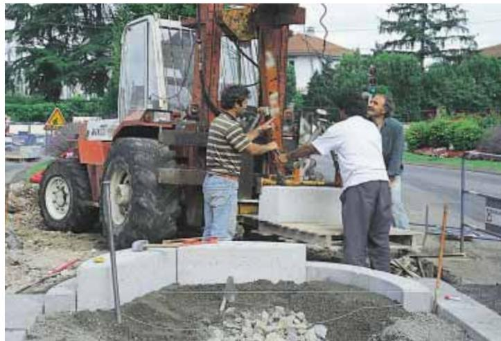
▲ La mise en œuvre des bordures, caniveaux et autres éléments en béton préfabriqué est faite sur un lit de béton de type B16 pour une assise optimale. Le poids et la taille de certains éléments ont nécessité l'utilisation de moyens de levage spécifiques, afin de positionner correctement les éléments.
