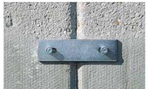
▲ Pour assurer la stabilité d'un îlot central d'une hauteur supérieure à la moyenne, les blocs en béton sont liés les uns avec les autres par des éclisses métalliques galvanisées.
