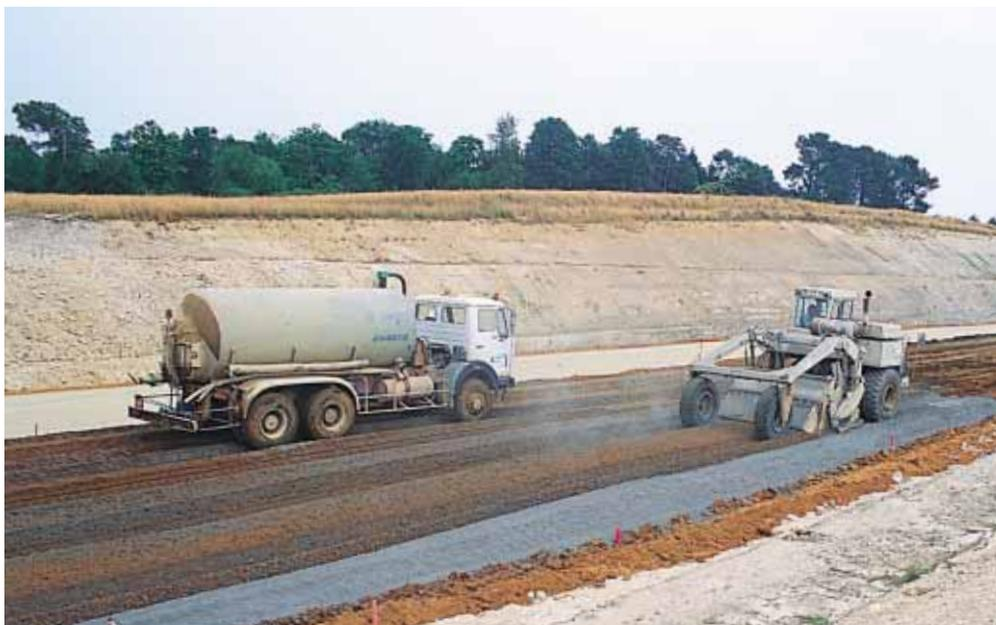
▲ Sur la section de l'A 84 entre Liffré et Saint-Aubin-du-Cormier, 60 000 m<sup>3</sup> de matériaux ont été traités en place avec un liant hydraulique routier.
