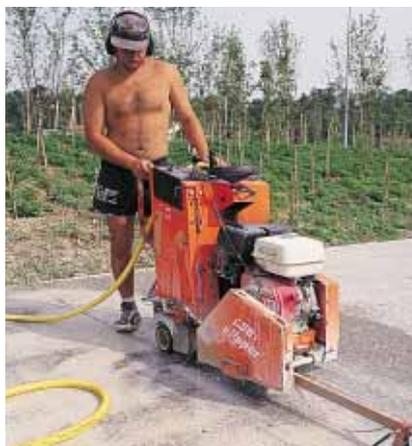
▲ Le sciage permet d'imposer tous les 5 m un joint de retrait net et rectiligne.
