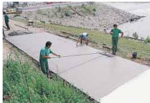
▲ Un lissage rapide évite de faire remonter en surface du béton les fines et la laitance qui pourraient compromettre le résultat esthétique final.
