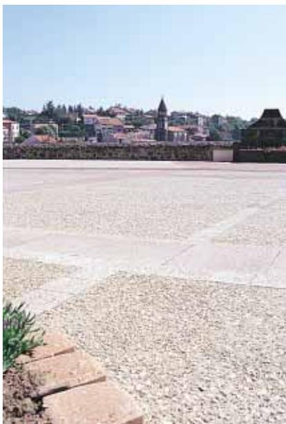
▲ Sayat : la chaussée réalisée en béton désactivé assure une plus grande sécurité aux piétons en obligeant les automobilistes à ralentir.
