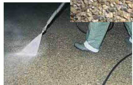
▲ Le lavage au jet d'eau sous pression permet de faire apparaître la couche de granulats superficielle.
