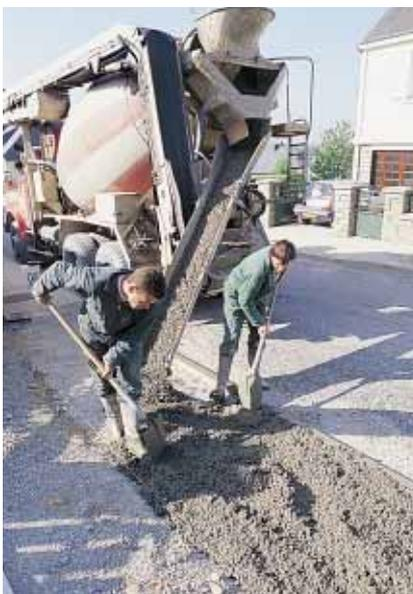
▲ Le béton frais acheminé sur le chantier est répandu et réparti sur le fond de forme à la pelle et au râteau.
