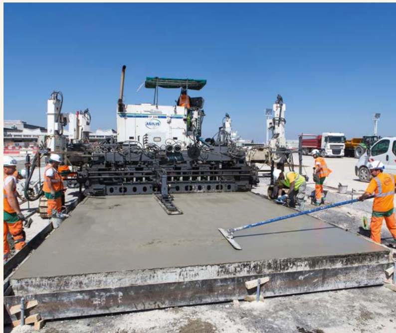
La Wirtgen SP-500 d'Agilis en action.
