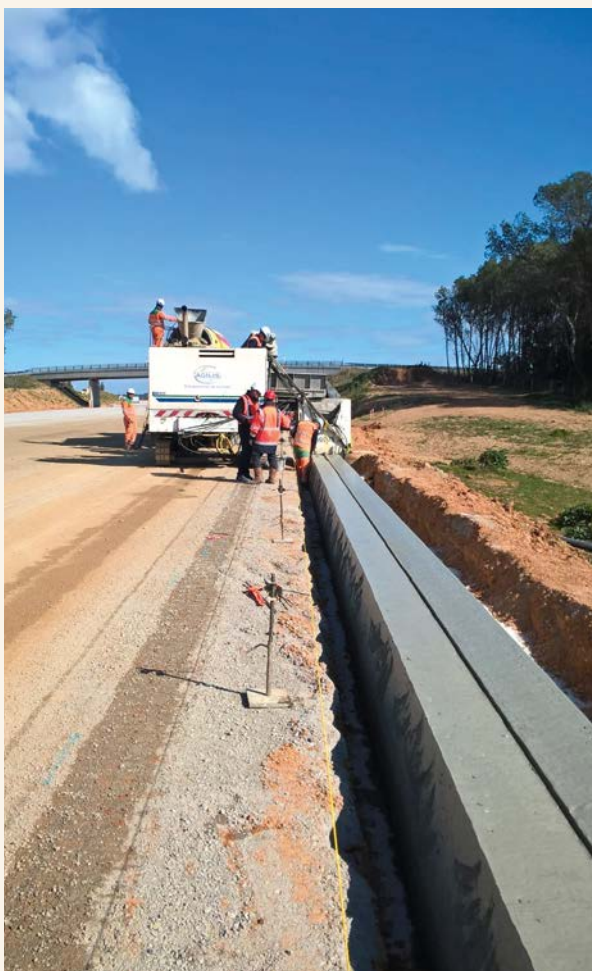
Au total, Agilis réalisera 90 km de séparateurs simples en béton adhérent (GBA) (photo du haut) et 12 km de caniveaux à fente (photo du bas).
