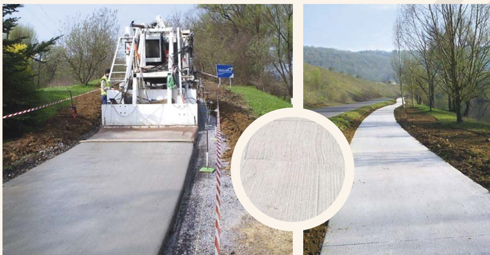
La réalisation de la piste cyclable a nécessité l'utilisation d'une Miller MI-1800 pour couler 500 mètres linéaires en moyenne par jour.
