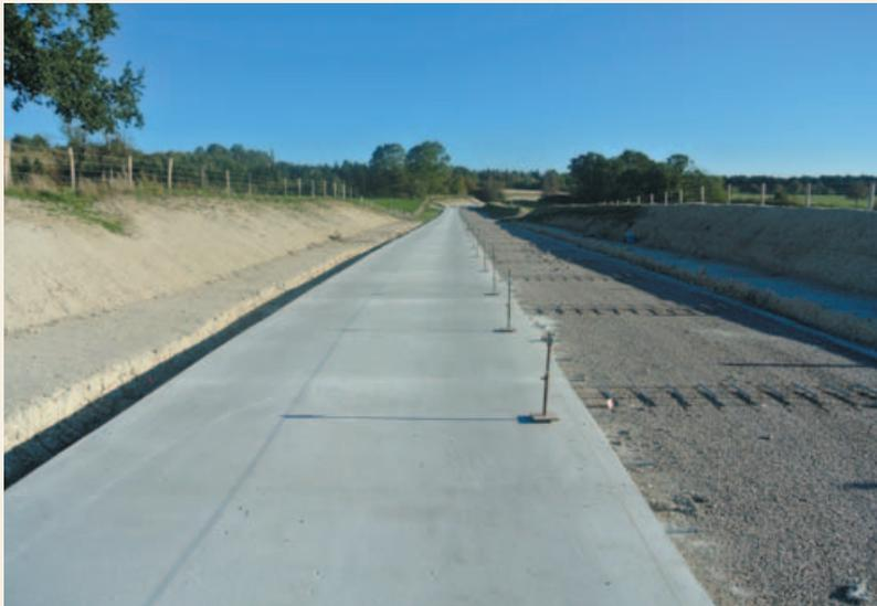
Quelque 13 000 poids lourds devraient emprunter chaque année cette déviation, réalisée en béton goujonné XF 2 (35/45), sur une épaisseur de 20 cm, avec un machine à coffrage glissant.
