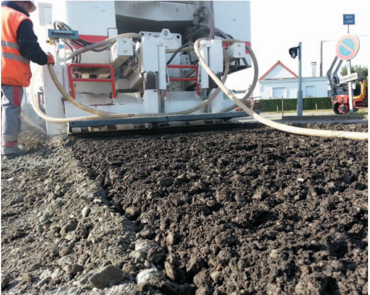
L'ARC® 1000 vu de l'arrière, avec le mélange homogène résultant du broyage de l'ancienne chaussée préalablement scarifiée.
