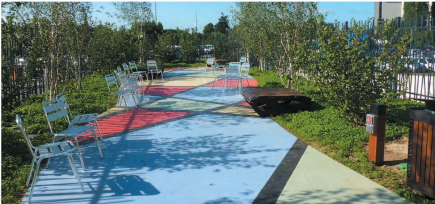
*Cet espace de détente de 80 m<sup>2</sup> en béton coloré et finement sablé arbore un arlequin rouge, noir, jaune et bleu en béton lissé, spatulé et gravé.*
