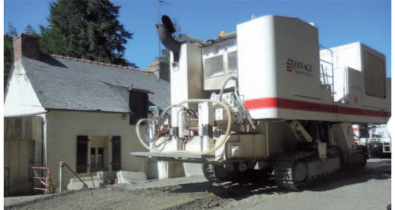
Vue de l'arrière de l'ARC 1000 d'Eiffage. Cette véritable « centrale mobile » décohesionne l'ancienne chaussée « transversalement et verticalement », mélange le liant avec le matériau en place avant l'homogénéisation de l'ensemble des constituants à l'aide d'un malaxeur intégré.
