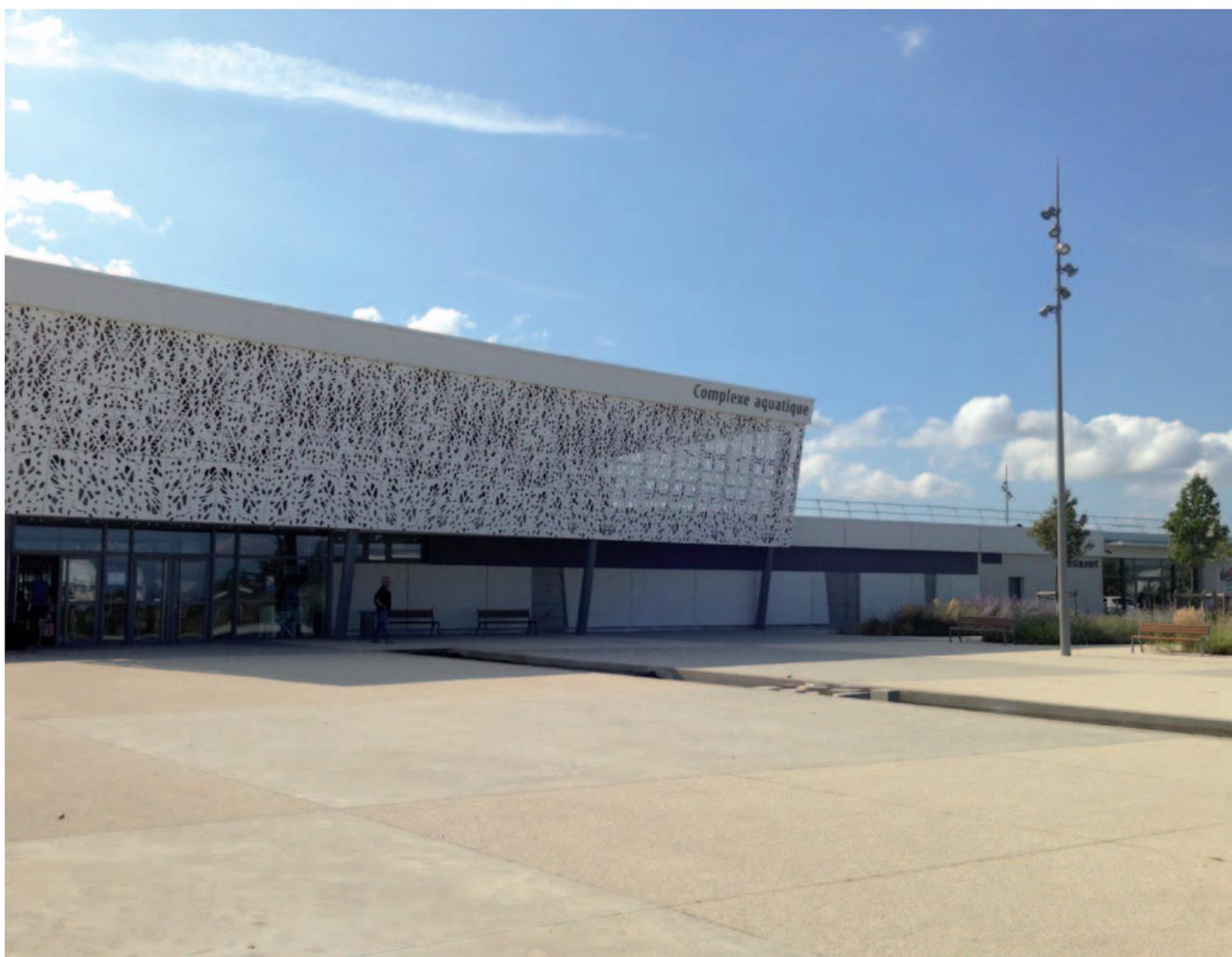
Le parvis du complexe nautique Diabolo de Bourg-de-Péage (Drôme) : réalisé en béton sablé (850 m<sup>2</sup>), il intègre un double effet visuel très original : un damier et, en alternance, un pochage au sol, dont le calepinage reproduit les motifs en dentelle et en mailles de la façade.
