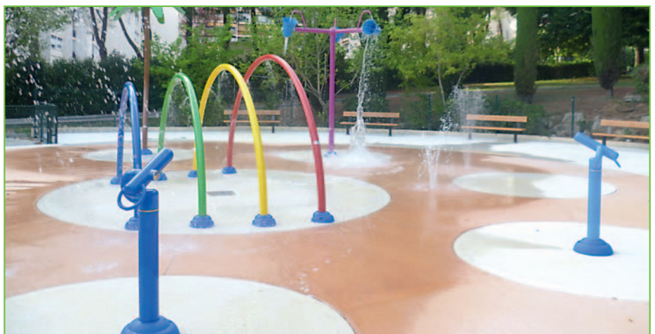
Le béton balayé teinté des jeux aquatiques du jardin de l'Etoile au Cannet Rocheville a été choisi pour sa résistance et sa bonne adhérence en milieu humide.
