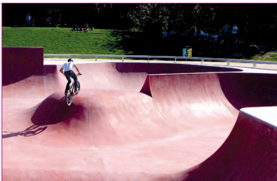
Caractérisé par son béton de couleur rouge et ses courbes, le « bowl » (qui s'inspire de la forme d'une piscine) permet de réaliser des figures. Sa profondeur est de 3 m.
