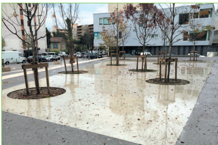
Originalité : des incrustations de verre coloré ont été réalisées dans les zones de béton poncé clair situées au pied des arbustes nouvellement implantés.
