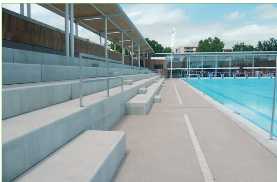
Au centre aquatique Grand Bleu de Cannes, le béton a été utilisé pour réaliser les abords des piscines (2 896 m 2 en désactivé) et les gradins (en sablé).
