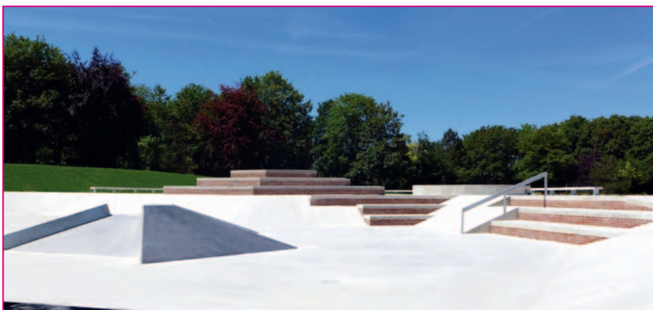
Vue du « ditch » (bassin de rétention) avec au-premier plan la « table ». Réalisée en béton coloré, elle permet de réaliser différents sauts, en fonction de ses pentes.
