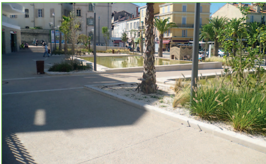
Les abords (2 021 m 2 au total) de la nouvelle place du commandant-Maria, dans le centre de Cannes, ont été réalisés en béton désactivé de teinte neutre.
