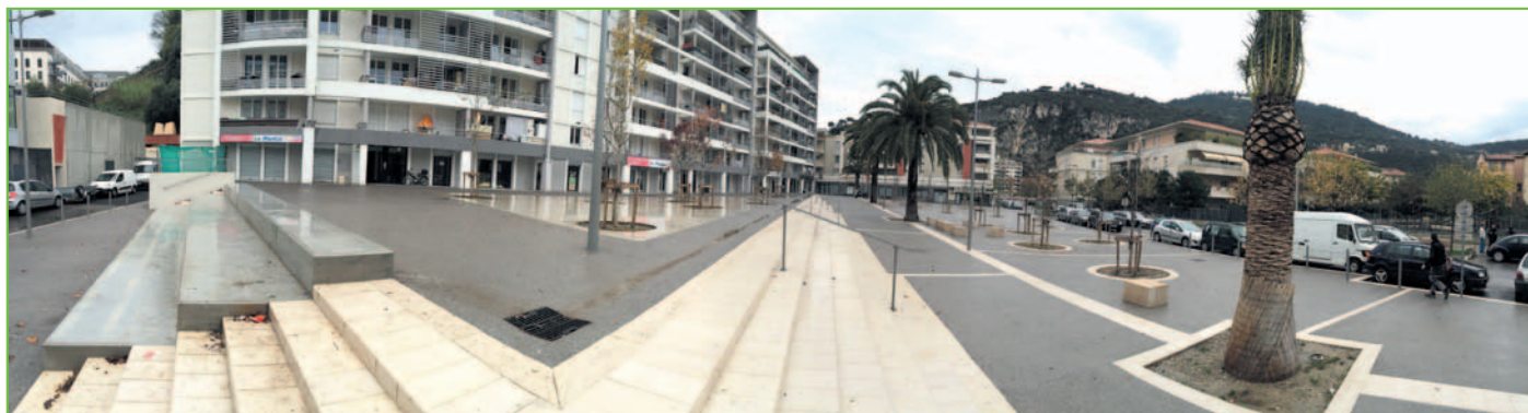
La nouvelle place du quartier de l'hôpital Pasteur, à Nice, a été réalisée en béton désactivé gris foncé. Elle est traversée en diagonale par un « emmarchement » en pierre calcaire.
