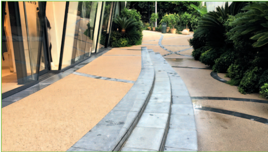
Les nouveaux cheminements piétonniers des jardins des Boulingrins à Monaco suivent un calepinage de pierres naturelles avec un remplissage de béton désactivé.
