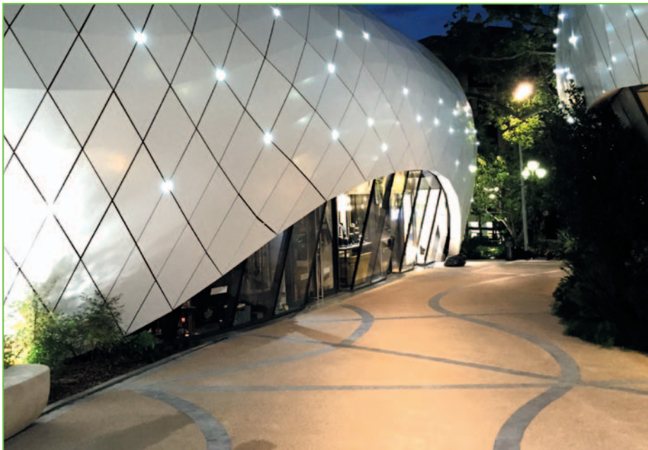
Végétalisés, les cheminements « serpentent » entre les pavillons blancs (de 220 à 600 m 2 ) en forme de galet conçus par l'architecte Richard Martinet.
