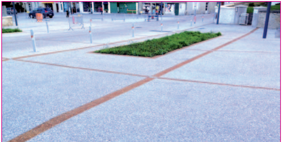
Blainville-sur-Orne : la place de l'Eglise a été traitée en béton désactivé avec un calepinage de bandes effet acier corten, colorées à l'aide d'une patine.
