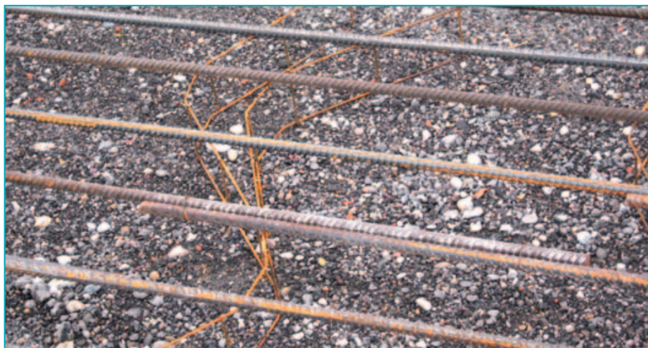
Les armatures du BAC sont ligaturées et positionnées sur des distanciers à mi-hauteur de la dalle.
