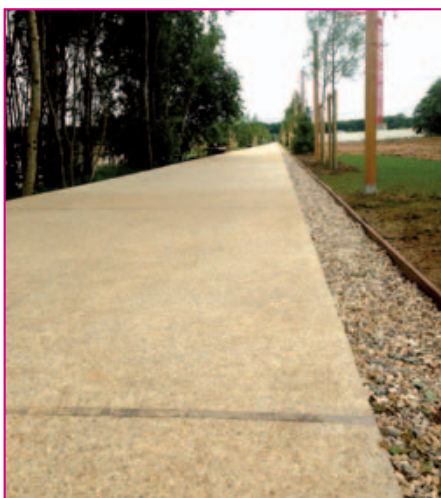
Bois d'Arcy : les joints de la grande allée ont été réalisés en bois d'azobé.
