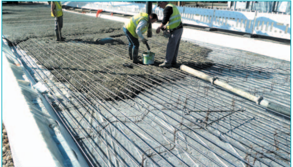
Après avoir placé le film plastique contre les bordures et positionné les armatures à mi-hauteur (sur des distanciers), le bétonnage de la plate-forme peut commencer.
