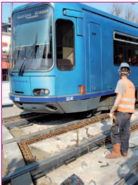
Rouen : 45 000 m 2 de béton ont été coulés sous circulation pour ne pas perturber la vie des usagers du Métrobus, une performance en termes de sécurité et une première en France.
