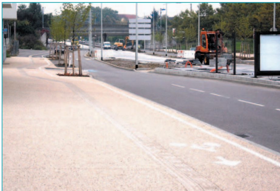
Piste cyclable et trottoir en béton désactivé bordent la plate-forme du BHNS.
