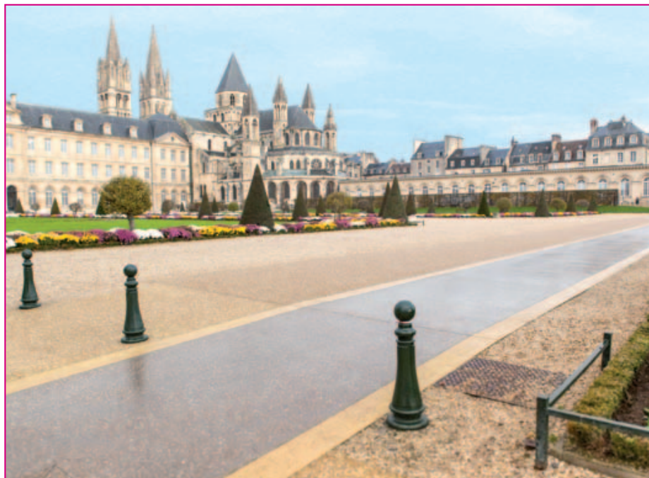
Caen : pour bien les identifier, les deux pistes en béton (piétons et vélos) ont fait l'objet d'une finition différente, tout en respectant la beauté du site.
