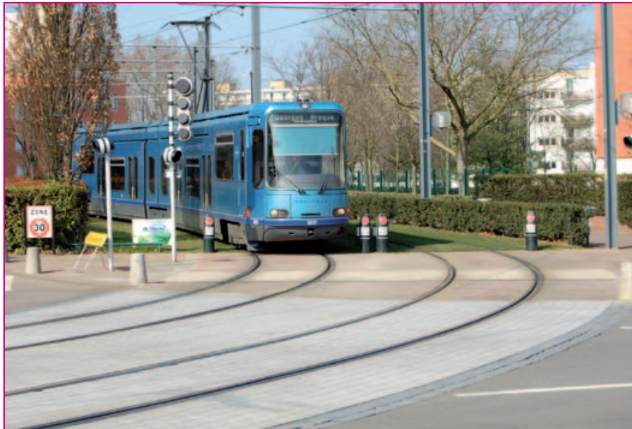
Rouen : la plate-forme courante (30 000 m 2 ) a été réalisée en béton brossé avec une finition colorée dans la masse en rouge ou jaune. Les carrefours ont été traités en béton imprimé, imitation pavés.
