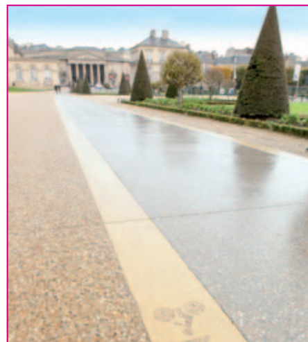
Caen : béton désactivé brossé à sec pour les piétons (à gauche), béton finition squamée pour les vélos (à droite).
