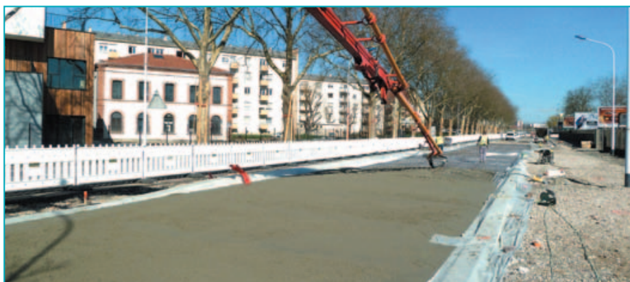
Une des contraintes rencontrées sur ce chantier a été la difficulté d'approvisionnement du béton. Sur certains secteurs, le recours à la pompe à béton était indispensable.
