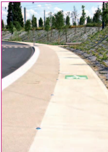
Le Havre : les 2 000 m 2 de pistes cyclables qui mènent au stade sont en béton gris, finition brossé fin.
