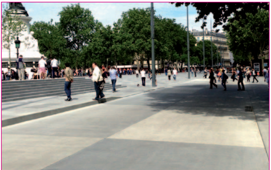
Paris : trois couleurs grises de bétons décoratifs ont été mises en œuvre, avec une trame tous les quatre mètres.
