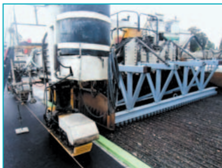
Mise en œuvre en pleine longueur à la machine à coffrage glissant (lot 2).
