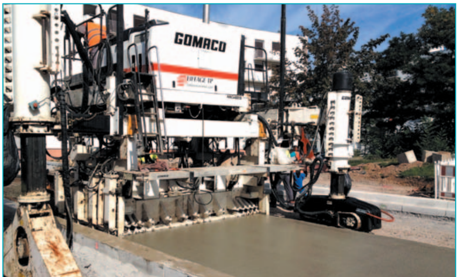
Mise en œuvre du béton, en demi-chaussée, à la machine à coffrage glissant (lot 3).
