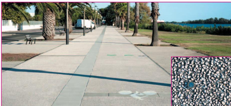
Les zones de repos avec bancs pour piétons en béton balayé contrastent avec la piste cyclable en béton désactivé. Réalisée il y a 20 ans, cette large promenade n'a pas pris une ride et s'est harmonieusement patinée.
