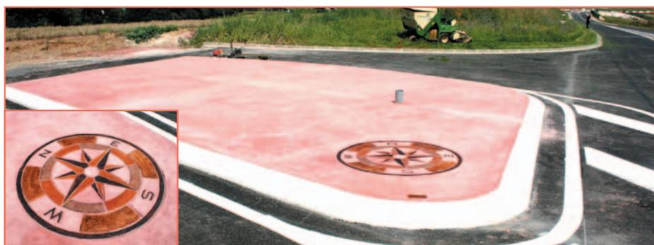
Près de la gare routière de Saint-Souplets, rond-point d'une voie de contournement réalisé en micro-chape. La rose des vents indique réellement les points cardinaux.
