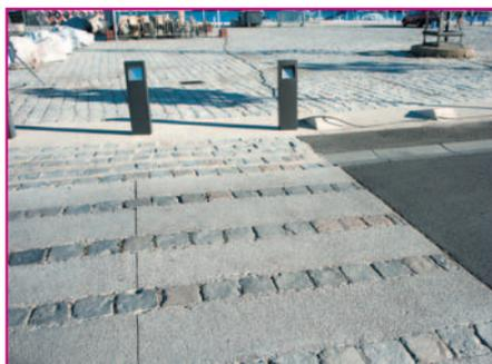
Tout autour du grand bassin du port, le béton désactivé a été réalisé avec des granulats en calcaire concassé et marié avec des gros pavés en pierre naturelle, semblables à ceux des quais.
