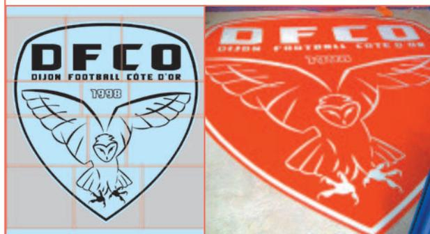
*travaillé avec un pochoir sur lequel nous avons pulvérisé, au moyen d'un pistolet à peinture, du béton ciré sous forme de poudre de finition* ».
