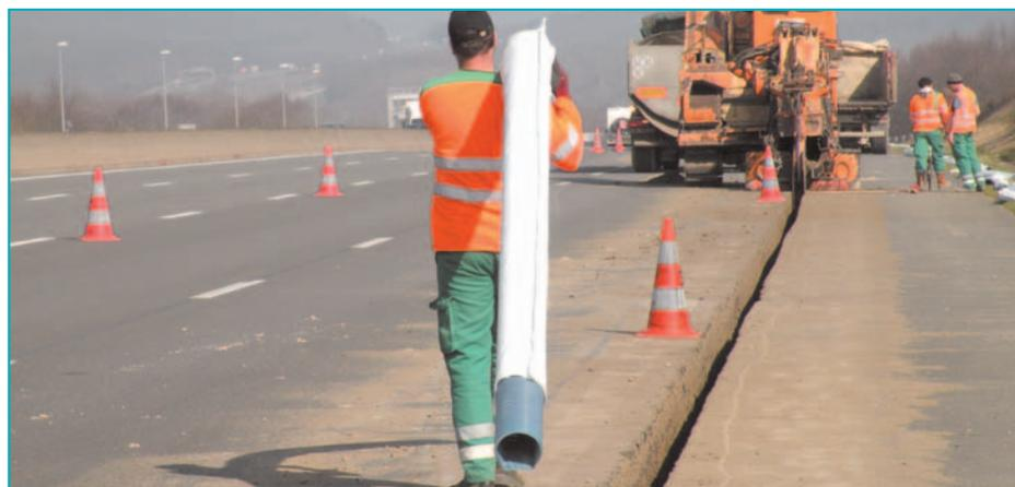
Un drain « chaussette » (entouré de géotextile), en polyéthylène annelé de 16 cm de diamètre, est déposé au fond de la tranchée.
