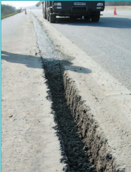
La tranchée a été remplie de 60 cm de béton drainant (au premier plan), puis sera recouverte par 20 cm de béton C30/37 (en arrière-plan).
