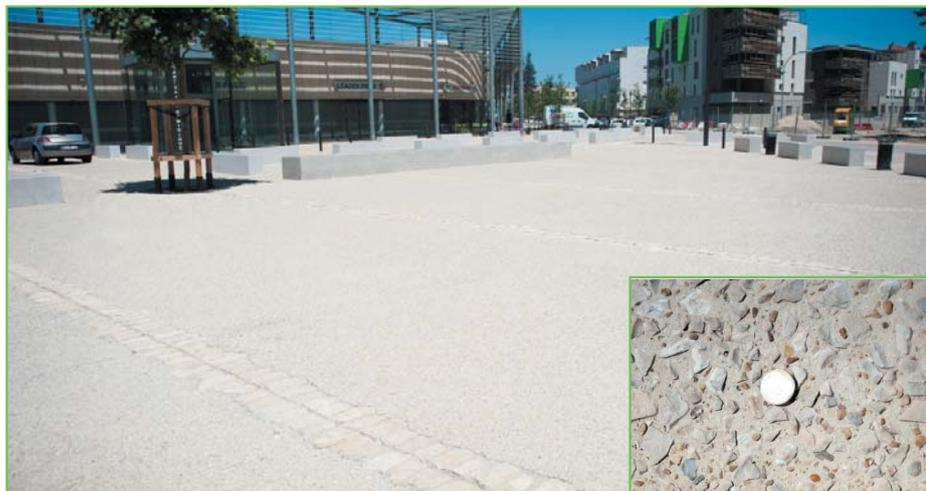
Nîmes (chemin bas d'Avignon) : la vaste place en béton désactivé, réalisé avec deux granulats de Lampourdier, vient créer une grande respiration urbaine jusqu'à la voie de circulation principale qui traverse le quartier.
