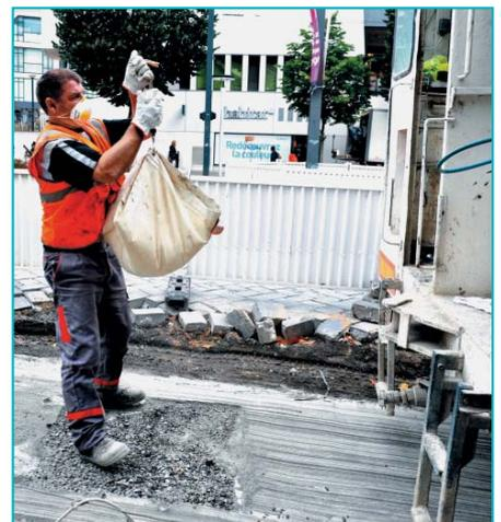
Le contrôle de la régularité de l'épandage et de la quantité de liant hydraulique routier est réalisé sur une surface témoin de 1 m<sup>2</sup> par la méthode dite « à la bâche ».
