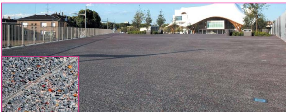
Des joints sciés et garnis d'un polymère découpent le parvis en surfaces d'environ 25 m<sup>2</sup>. Projetés dans le béton frais avant le dernier talochage et la désactivation, des éclats de verre colorés émergent de la pâte cimentaire avec des granulats noirs.
