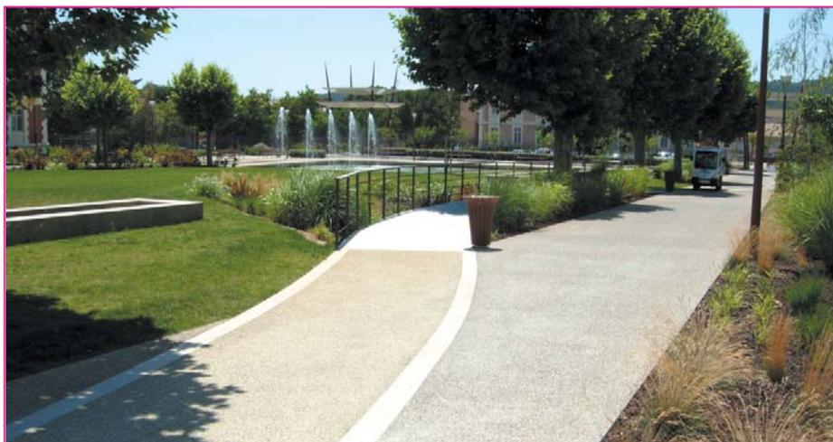
Grâce à sa souplesse d'emploi et à des coffrages adaptés, le béton désactivé sait adopter des formes complexes.
