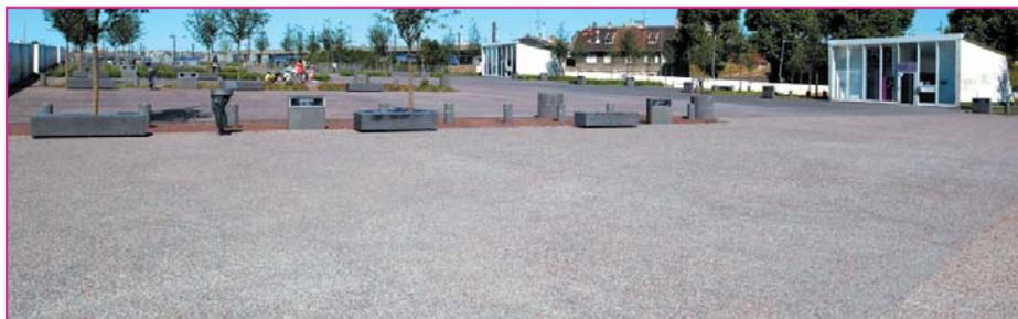
Les joints permettent de séparer des bétons aux teintes différentes.
