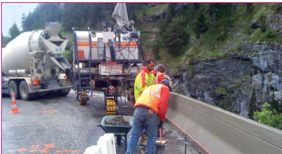
Toutes les 20 à 30 minutes, un nouveau camion-toupie vient alimenter la machine à coffrage glissant. Au total, six toupies se sont relayées pour alimenter ce chantier en continu. Les 460 mètres de la GBA ont ainsi pu être construits en deux jours seulement.
