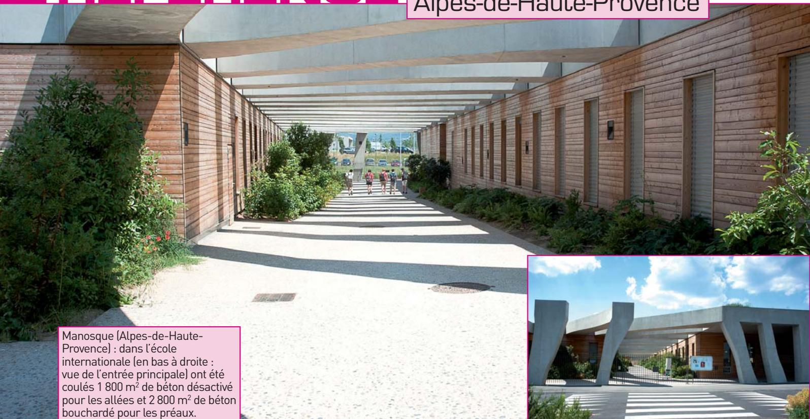
Manosque (Alpes-de-Haute-Provence) : dans l'école internationale (en bas à droite : vue de l'entrée principale) ont été coulés 1 800 m<sup>2</sup> de béton désactivé pour les allées et 2 800 m<sup>2</sup> de béton bouchardé pour les préaux.
