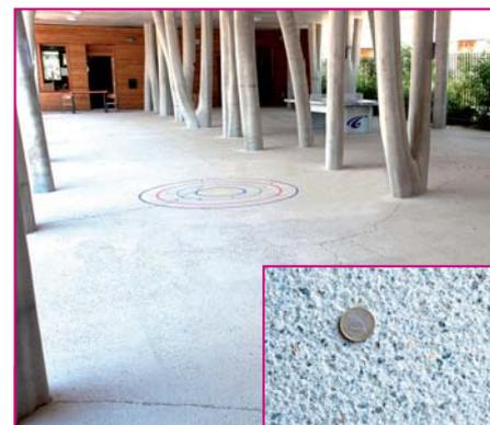
Ne voulant pas de joints de retrait, les architectes ont souhaité que le béton bouchardé des préaux se fissure tout seul au droit des poteaux qui ressemblent à des troncs d'arbres. Comme pour en figurer les racines.
