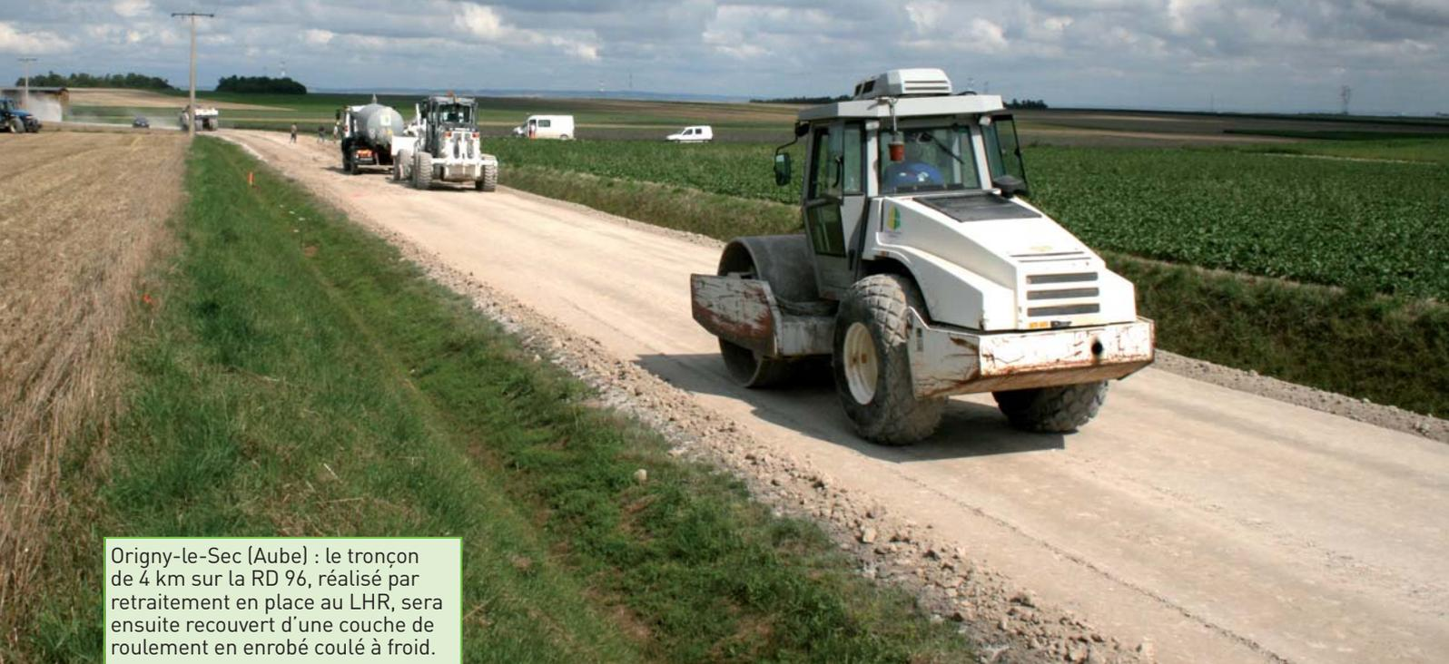
Origny-le-Sec (Aube) : le tronçon de 4 km sur la RD 96, réalisé par retraitement en place au LHR, sera ensuite recouvert d'une couche de roulement en enrobé coulé à froid.
