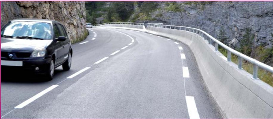
La souplesse du procédé et celle du matériau béton permettent d'épouser les courbes de cette route de montagne très sinueuse.
