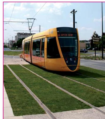
La plate-forme possède des zones engazonnées, avec un dispositif d'arrosage intégré, qui sont délimitées par des zones en béton désactivé.
