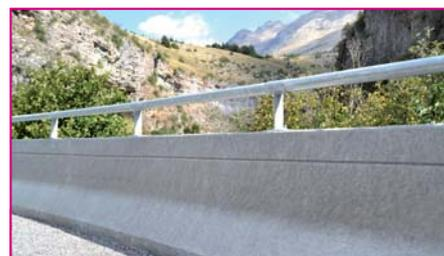
Le profil chasse-roues en partie basse et rampe inclinée en partie haute contribue à la sécurité des usagers.
