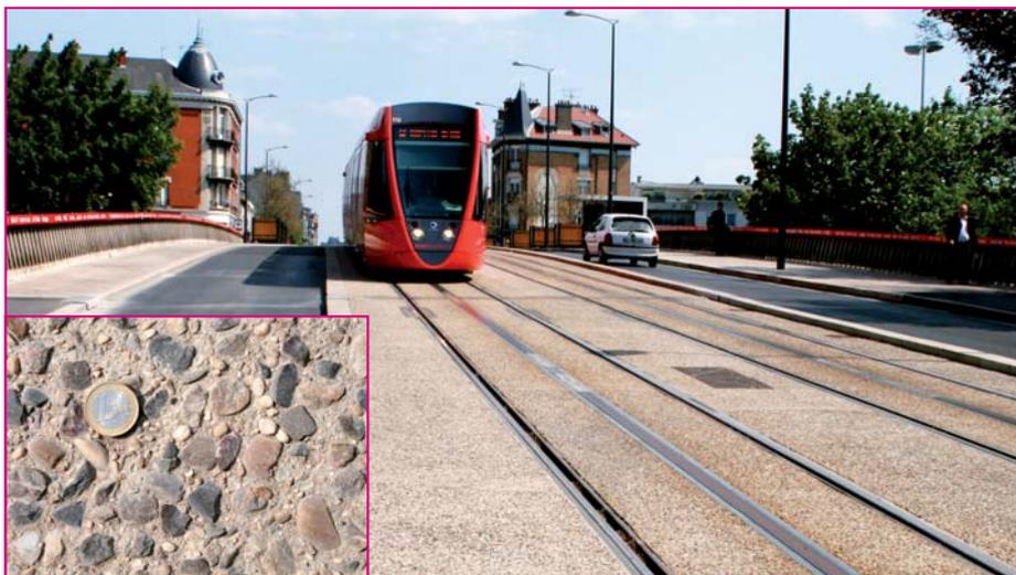
En zone circulaire, le tramway roule sur du béton désactivé moucheté, dont l'aspect provient d'un mélange de granulats 0/14 de la gravière de Nordhouse (Alsace).
