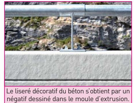
Le liseré décoratif du béton s'obtient par un négatif dessiné dans le moule d'extrusion.
