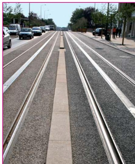
Intégré harmonieusement dans le béton désactivé, un troisième rail assure l'alimentation des rames sur 1,9 km de longueur en centre-ville.
