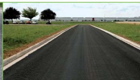
À gauche, l'ancienne chaussée très dégradée et, à droite, la nouvelle voie retraitée en place au LHR, recouverte d'enrobé coulé à froid.
