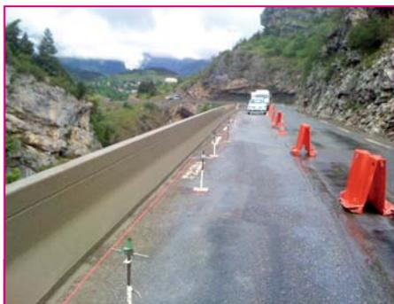
La machine à coffrage glissant est guidée par un fil posé sur des potences implantées sur la chaussée.
