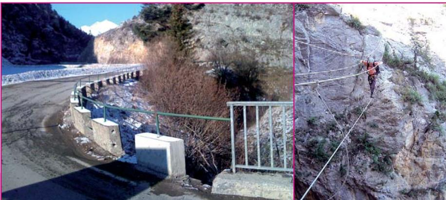
À gauche : les anciens dés en béton, reliés par des barres d'acier, étaient censés apporter une protection suffisante contre les risques de chute des véhicules.
