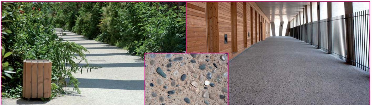
Le béton désactivé des allées, aussi bien couvertes qu'à l'air libre, a été réalisé avec des granulats assez gros (20/40) provenant de la Durance toute proche. À noter que la couleur du matériau passe du clair au foncé, selon l'exposition au soleil.
