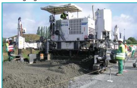
La machine à coffrage glissant règle et vibre le béton sur une largeur de 4,50 mètres et sur une épaisseur de 22 cm.
