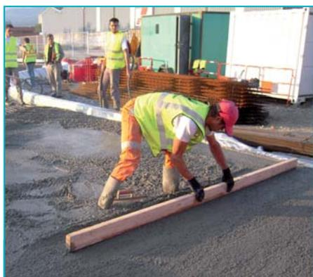
Phase de tirage et de réglage du béton à la main, au moyen d'une poutre.
