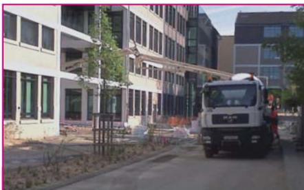
L'étroitesse des accès impose d'utiliser la technique du pompage du béton.
