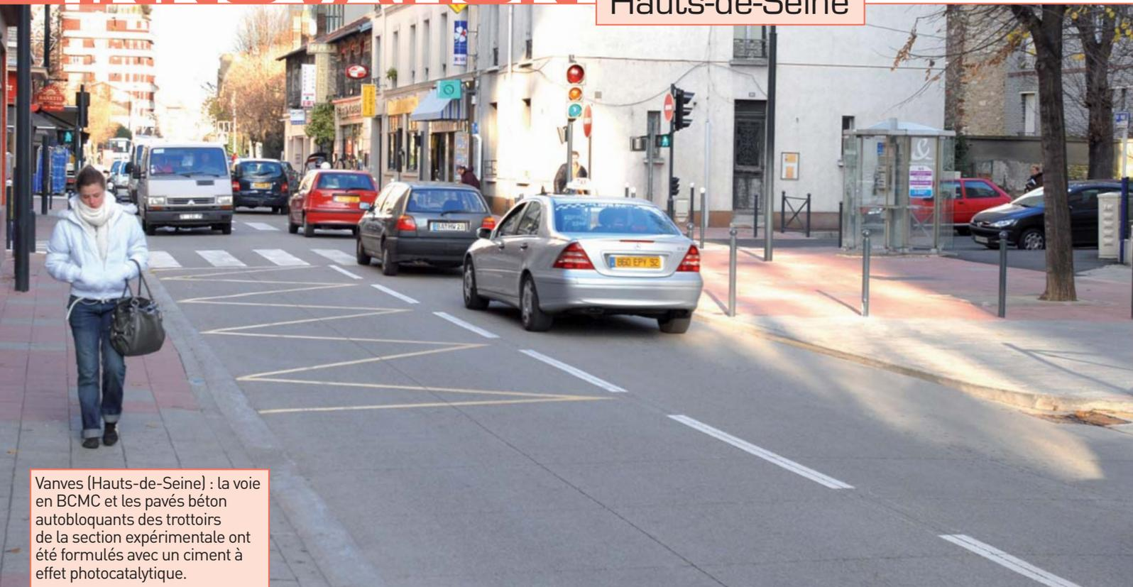
Vanves (Hauts-de-Seine) : la voie en BCMC et les pavés béton autobloquants des trottoirs de la section expérimentale ont été formulés avec un ciment à effet photocatalytique.
