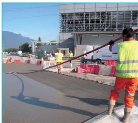
Opération de lissage du béton à l'aide d'un balai à long manche.
