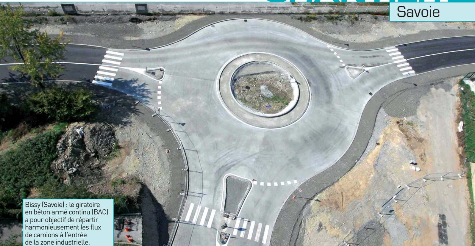
Bissy (Savoie) : le giratoire en béton armé continu (BAC) a pour objectif de répartir harmonieusement les flux de camions à l'entrée de la zone industrielle.
