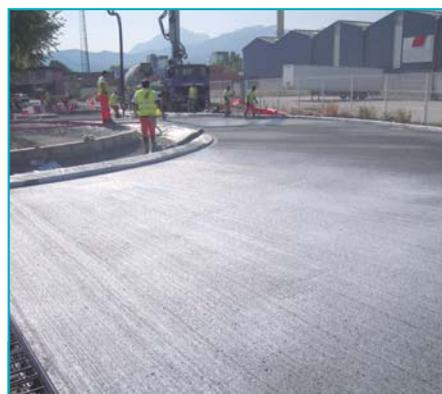
Vue du béton après application d'un produit de cure.
