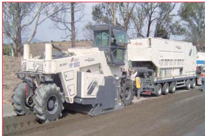
Retraitement de chaussée au liant hydraulique (Mexique).
