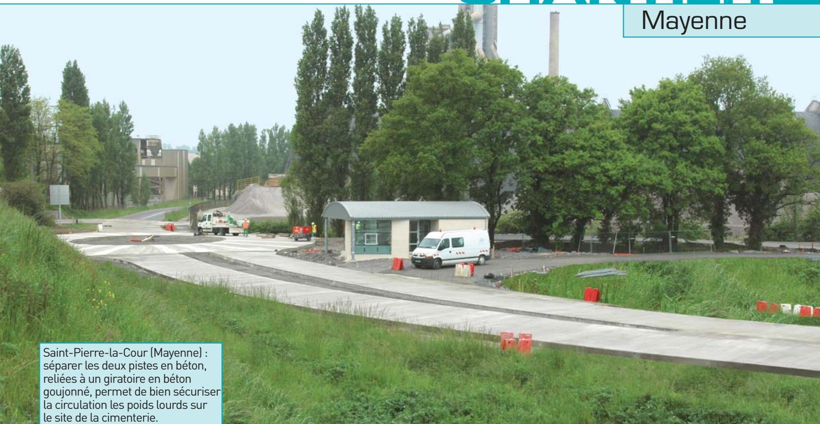
Saint-Pierre-la-Cour (Mayenne) : séparer les deux pistes en béton, reliées à un giratoire en béton goujonné, permet de bien sécuriser la circulation des poids lourds sur le site de la cimenterie.
