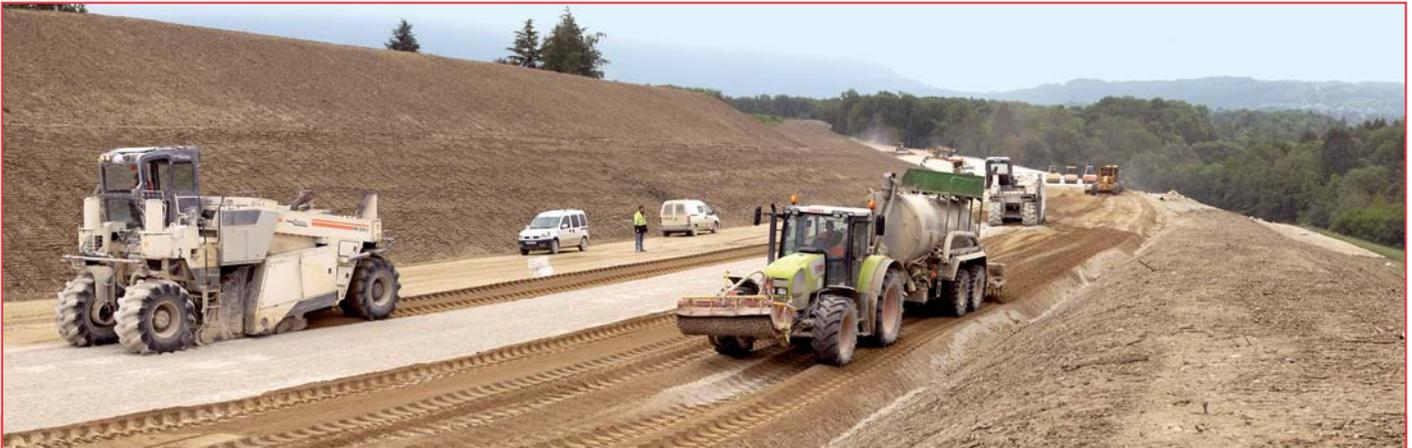
Tronçon de l'autoroute A 41 Nord (France) : 11 000 tonnes de liant hydraulique routier ont été utilisées pour réaliser le traitement de 19 km de couche de forme.
