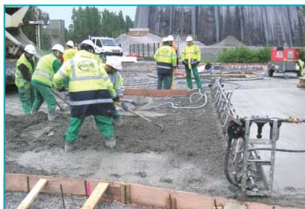
Une règle vibrante de 9 m de long assure la consolidation uniforme du béton.
