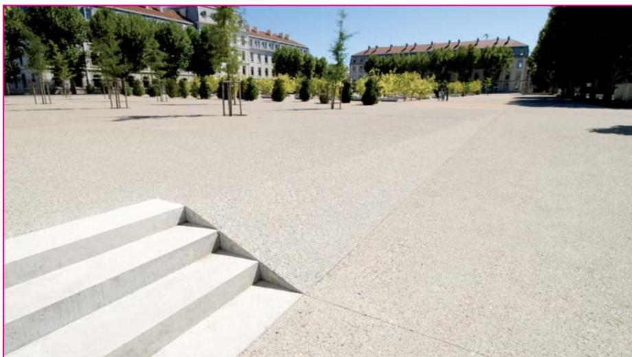
Grâce à sa grande malléabilité, le béton désactivé permet de réaliser des plans inclinés servant à intégrer, de façon harmonieuse, les ruptures de pente.
