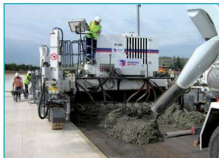
La machine à coffrage glissant est alimentée par des toupies à l'avant.
