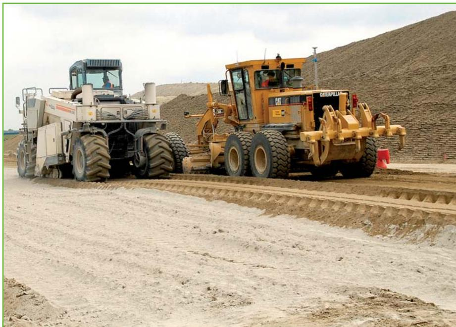
Le pulvimixeur mélange intimement le matériau, le liant hydraulique routier et l'eau.
