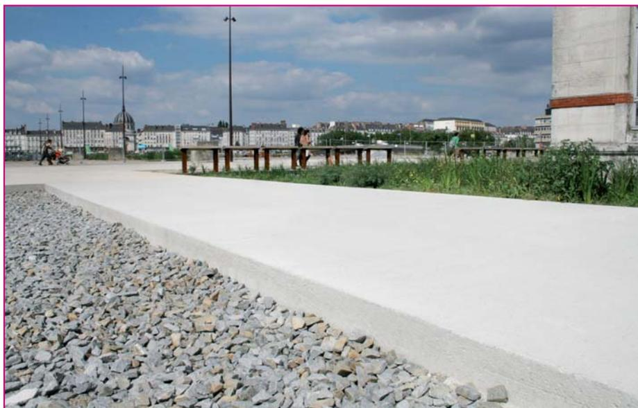
Dalle des esplanades, en béton balayé d'une épaisseur standard de 23 cm.
