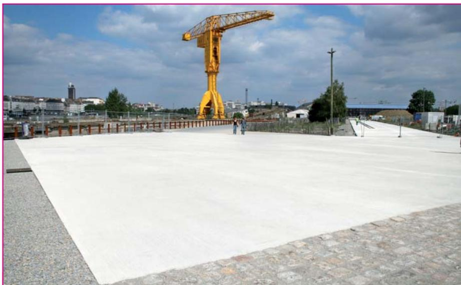
Béton désactivé avec granulats 20/40 (à gauche), béton balayé (au milieu) et pavés béton 14 x 14 cm (à droite). En arrière-plan : l'ancienne grue "Titan" des chantiers navals devenue l'emblème de cette partie de l'île de Nantes.
