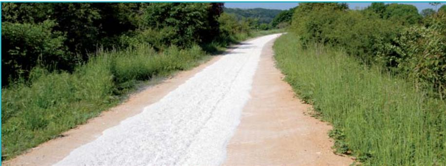
La stabilisation du sol est réalisée par épandage régulier d'un liant hydraulique routier, composé de chaux hydraulique naturelle et d'un liant à effet pouzzolanique.
