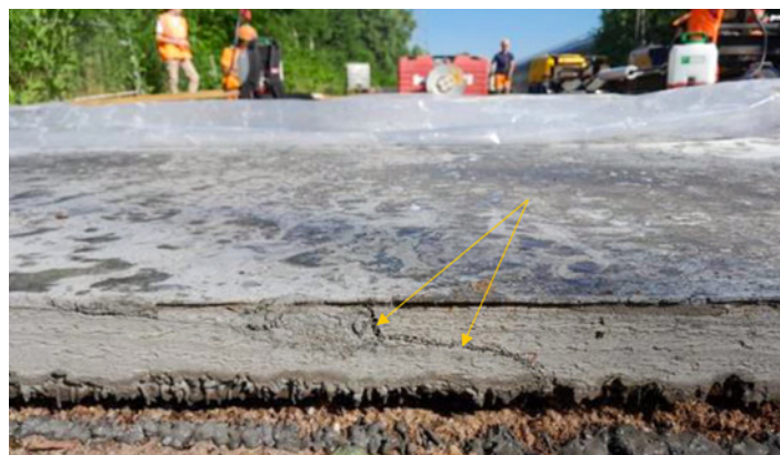
Figure 16 : exemple d'un mauvais remariage des couches BFUP pouvant remettre en cause l'étanchéité.
