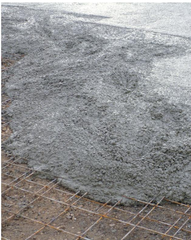
**CI-DESSUS :** Chantier expérimental Recybéton de Chaponost (69). Bétons - incorporant de 0 à 100 % de granulats recyclés - coulés en un dallage de 18 cm d'épaisseur à usage de parking pour véhicules lourds.
