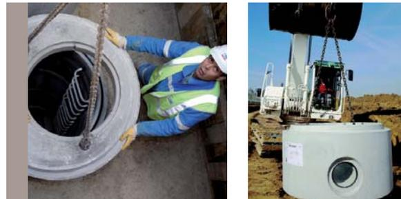
Les regards de visite sont de section circulaire et d'un diamètre intérieur minimal de 1 000 mm (condition pour être qualifiés de visitables).
