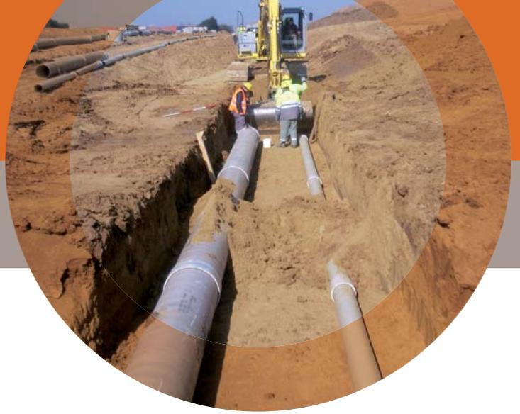
L'assemblage entre tuyaux est réalisé à l'aide de bagues d'étanchéité en caoutchouc, qui sont généralement intégrées au produit lors de sa fabrication, afin de garantir sur chantier un emboîtement et une étanchéité efficaces et pérennes.
