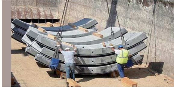
Les voussoirs peuvent également être utilisés pour constituer des ouvrages verticaux : cheminées de descentes, puits d'accès, puits de ventilation.
