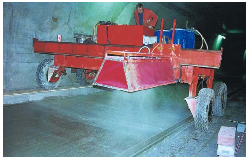
Mise en œuvre de la chaussée en béton armé continu.
