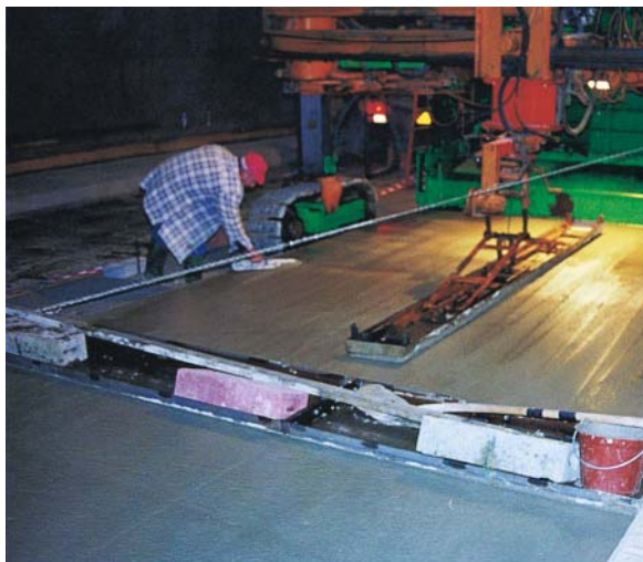
Mise en œuvre de la chaussée en béton armé continu.
