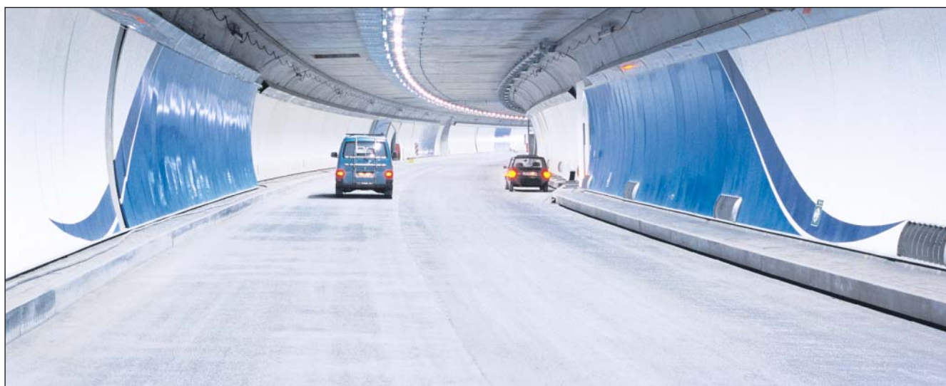
Chaussée en béton armé continu, tunnel de Cointe, Belgique, 2001.
