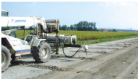
Matériel pour réaliser la préfi ssuration du matériau retraité.
