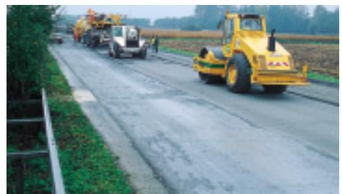
Le passage des compacteurs termine la mise en œuvre des matériaux recyclés en place.
