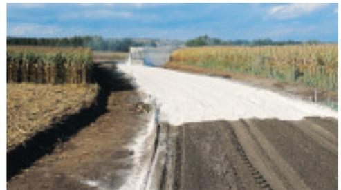
Épandage de liant pulvérulent sur la chaussée fragmentée à retraiter.
