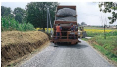
Protection de la structure retraitée par la réalisation d'un enduit superficiel.
