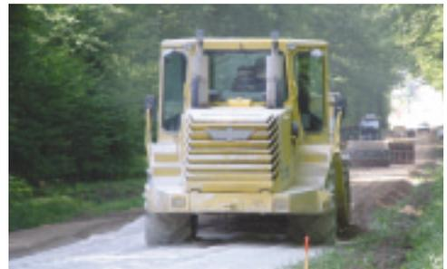
Après épandage du ciment, ou du liant hydraulique routier, le malaxage permet d'obtenir une structure homogène.
