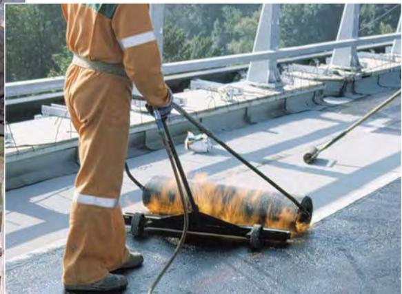
Sur les ouvrages d'art courants, les procédés les plus utilisés sont les procédés asphalte, les feuilles préfabriquées monocouches ou recouvertes d'asphalte. Les films minces adhérents au support sont surtout réservés à des zones contournées comme les trottoirs, les caniveaux de corniches, caniveaux etc. Les procédés par moyen à haute cadence sont adaptés aux grands ouvrages.
