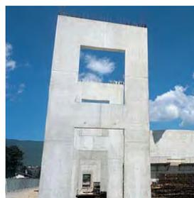
Les bétons autoplaçants (BAP) sont des bétons très fluides, homogènes et dont la consistance mesurée par l'essai d'étalement au cône d'Abrams est compris généralement entre 600 et 750 mm, ce qui permet de les mettre en œuvre sans vibration.
