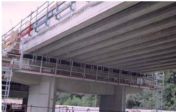
La longueur totale des tabliers rendus continus doit rester inférieure à 90 mètres. Les tabliers à une voie de circulation comportent 7 poutres par travée et ceux à deux voies 13 poutres. Les premiers ouvrages de ce type ont été réalisés en 2003 et 2004 sur la LGV Est.
