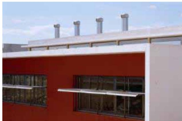
registre motorisé asservi à la vitesse du vent et à la température assurent la mise en dépression des circulations et permettent un balayage des classes. Toute l'année, quelle que soit la saison, les salles de classe profitent ainsi d'une température constante. Le système de ventilation est par ailleurs très hygiénique car il n'utilise aucun conduit, ce qui évite les problèmes d'aéroulque.
