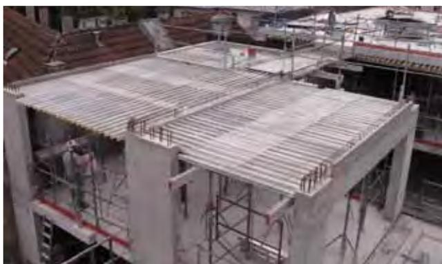
Dimensionnées pour supporter une charge de 1 t/m<sup>2</sup>, les dalles de plancher ont une épaisseur de 30 cm. Le système de plancher chauffant-rafraîchissant met à profit l'inertie thermique des dalles en béton armé et joue un rôle primordial dans les performances énergétiques de ce bâtiment BBC.
