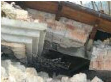
**Fig. 24 - Dislocation des maçonneries lors des séismes d'Italie de 2009 et 2002**
