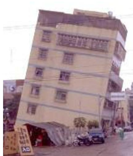
**Fig. 9 - Effondrement dû à la torsion (séisme de Taïwan 1999)**
