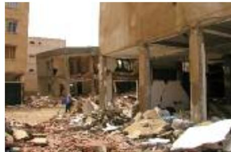
**Fig. 44 - Éclatement des panneaux de remplissage en maçonnerie (séisme de Boumerdès, Algérie 2003)**
