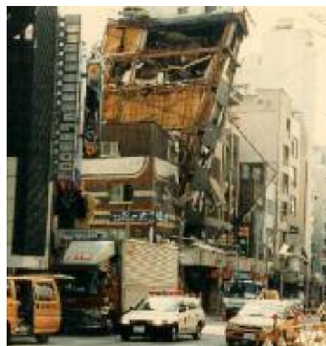
Fig. 5 - Dommages dus à la résonance du bâtiment avec le sol (séisme de Kobé, 1995)
