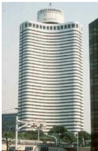
**Fig. 15 - Variation progressive de la rigidité horizontale des niveaux**
