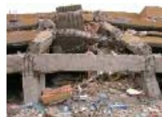
**Fig. 39 - Effondrement des ossatures en béton armé non confiné (séismes d'Izmit, Turquie 1999 et de Boumerdès, Algérie 2003)**
