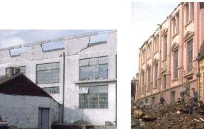
**Fig. 31 - Chute partielle d'un acrotère sans chaînages verticaux et chute totale d'un acrotère sans couronnement (séisme du Chili, 1960).**
