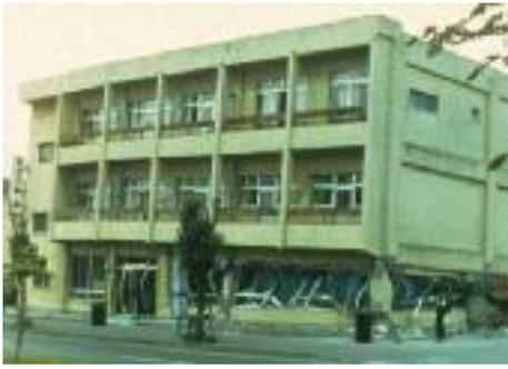
**Fig. 17 - Dommages dus à la torsion du rez-de-chaussée d'un immeuble (séisme de Tokachi-Oki, Japon 1968) et exemples d'une répartition correcte des éléments rigides.**
