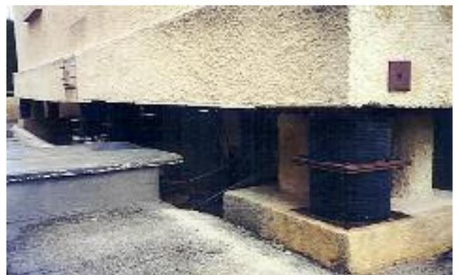
**Fig. 16 - Constructions isolées à la base**
