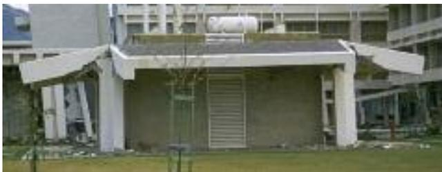
**Fig. 7 - Rupture de porte-à-faux (séisme de San Fernando, Californie 1971)**
