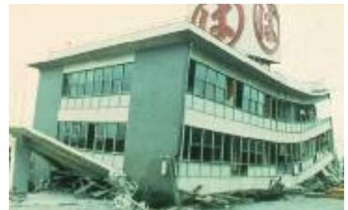
**Fig. 18 - Dommages aux rez-de-chaussée « souples » (séismes de Kobé, Japon 1995 et de Tokachi-Oki, Japon 1968)**
