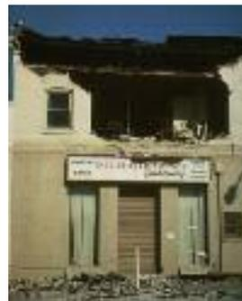
**Fig. 26 - Dislocation des murs à partir de baies non encadrées, (séismes d'Anchorage, Alaska 1964 et de San Fernando, Californie 1967)**
