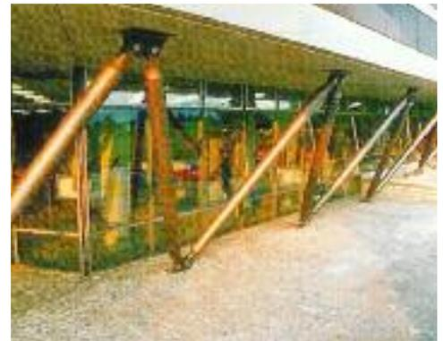
**Fig. 19 - Contreventement ayant pour but d'augmenter la rigidité horizontale du rez-de-chaussée**
