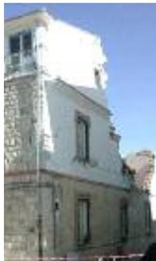
Dans un premier temps, les panneaux de maçonnerie sont fissurés diagonalement (fig. 25), car sous l'action des forces horizontales, ils ont tendance à prendre la forme d'un parallélogramme, dont une diagonale est tendue et l'autre comprimée. La
