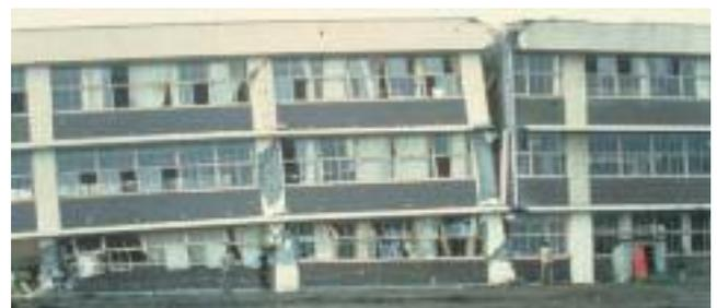
**Fig. 13 - Dommages dus à l'entrechoquement de blocs contigus (séismes de Boumerdès, Algérie 2003 et de Tokachi-Oki, Japon 1968)**
