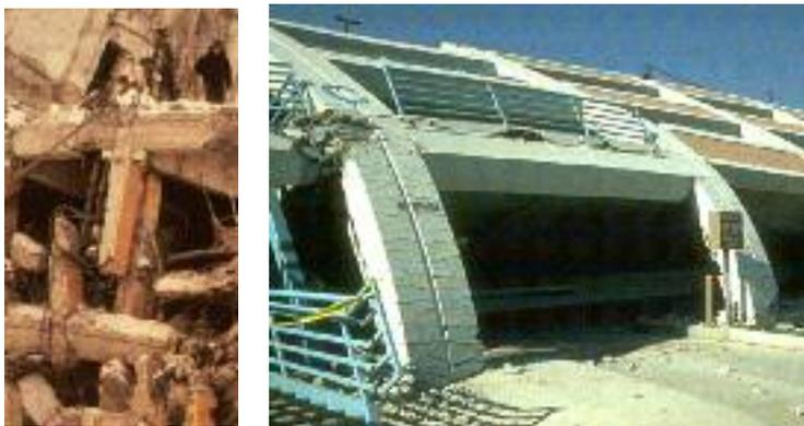
**Fig. 40 - Comparaison d'un comportement fragile (rupture instantanée) d'une ossature non confinée et du comportement ductile (plastique) d'une ossature confinée. L'effondrement de cette dernière construction est dû à une erreur de conception et non d'exécution : effet de poteau court à l'intérieur du bâtiment (séismes de Spitak, Arménie 1988 et de Northridge, Californie 1994)**
