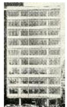
**Fig. 21 - Structure de même rigidité horizontale à tous les niveaux**
