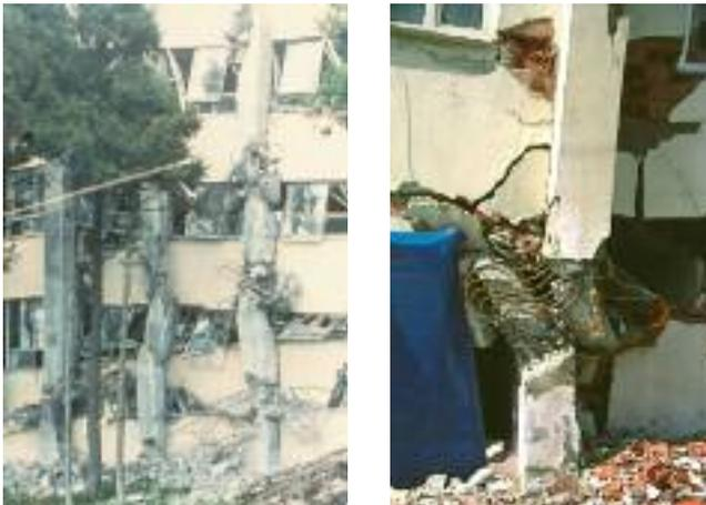
**Fig. 43 - Non-respect du principe « poteau fort - poutre faible » (séismes de Tokachi-Oki, Japon 1968 et d'Izmit, Turquie 1999)**
