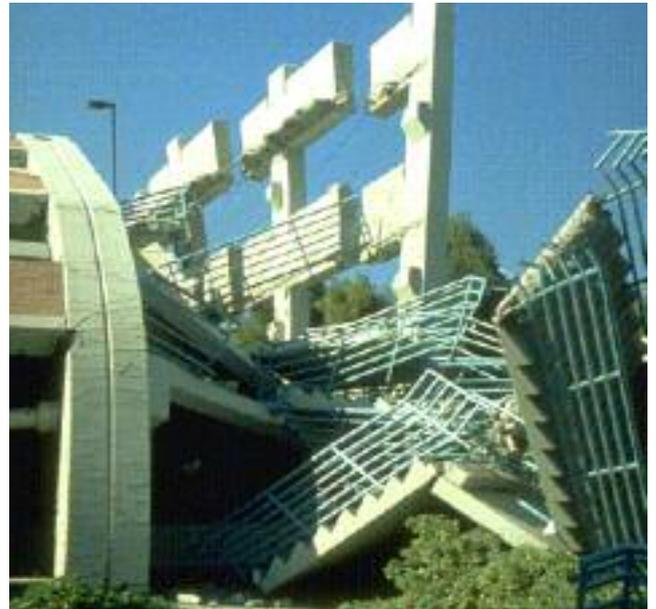
**Fig. 10 - Effondrement d'un bâtiment conforme aux règles parasismiques (séisme de Northridge, Californie 1994)**
