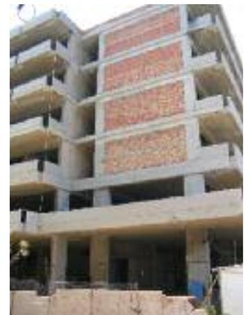
**Fig. 45 - Raidisseurs en béton armé destinés à prévenir ou retarder l'éclatement des panneaux de remplissage en maçonnerie (à gauche: après le séisme du Mexique, 1985)**
