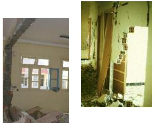
**Fig. 32 - Éclatement de cloisons en maçonnerie, (séismes d'El Asnam et de Boumerdès, Algérie 1980 et 2003)**
