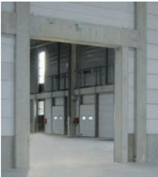
Par ailleurs, le maître d'ouvrage a tenu à ce que les encadrements de portes à quais soient réalisés en voiles béton, pour une raison de solidité face aux impacts des poids lourds.
