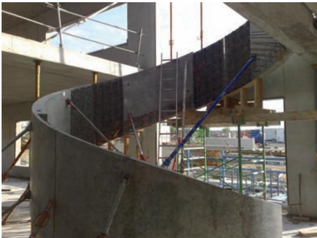
Ici, pour l'escalier intérieur monumental des bureaux, la plasticité du béton est un réel atout pour exécuter la forme libre du dessin. Cet escalier a été réalisé en éléments préfabriqués assemblés sur place.
