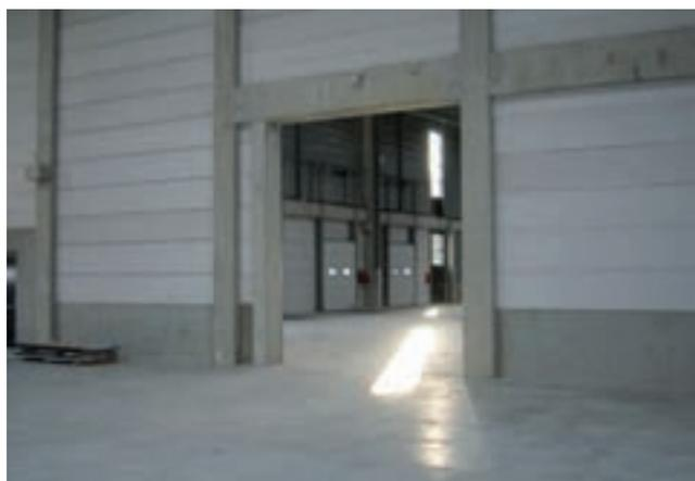
Ces panneaux préfabriqués de grande dimension permettent de réaliser des façades sobres et élégantes, et leur montage est très rapide.
