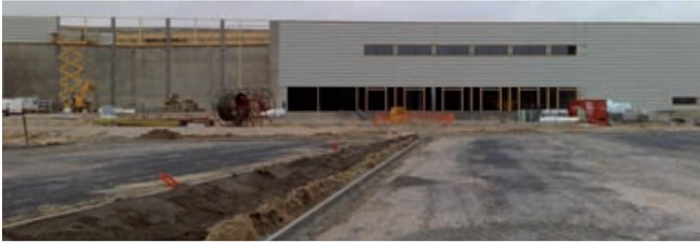
Toute la façade des bureaux a été réalisée avec des panneaux préfabriqués et une isolation par l'extérieur. Ce procédé a permis d'obtenir une grande inertie et d'améliorer les performances thermiques du bâtiment.
