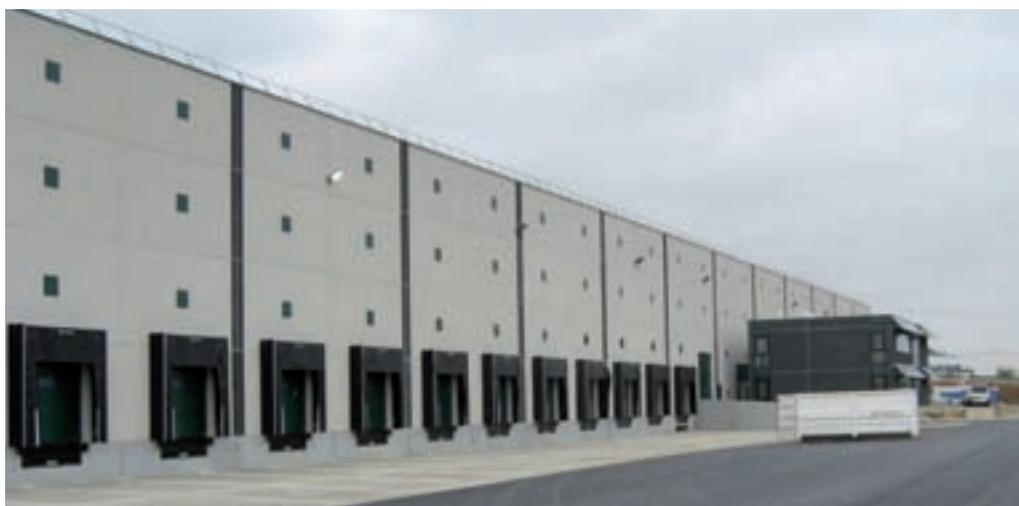
Les façades en panneaux de béton sont la meilleure réponse en termes de résistance à l'effraction et aux chocs, de durabilité et d'entretien sans oublier **les fonctions d'écran thermique et protection au feu**. Grâce à leur système de fixation à la charpente, ils autorisent les démontages, avec possibilité de réemploi, et facilitent les extensions de bâtiments (cf. *Murs séparatifs coupe-feu et façade écran thermique en béton*, Réf B67, CIMbéton, 2007).
