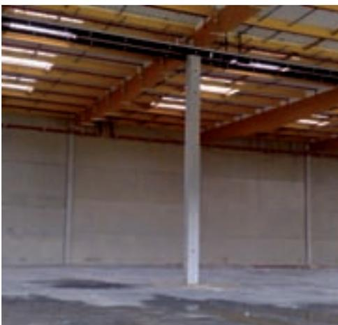
Ici, les poteaux de structure et les panneaux de recouplement sont en béton, comme sur tous les projets nécessitant une grande tenue au feu, notamment les projets d'entrepôt classés 1510.
