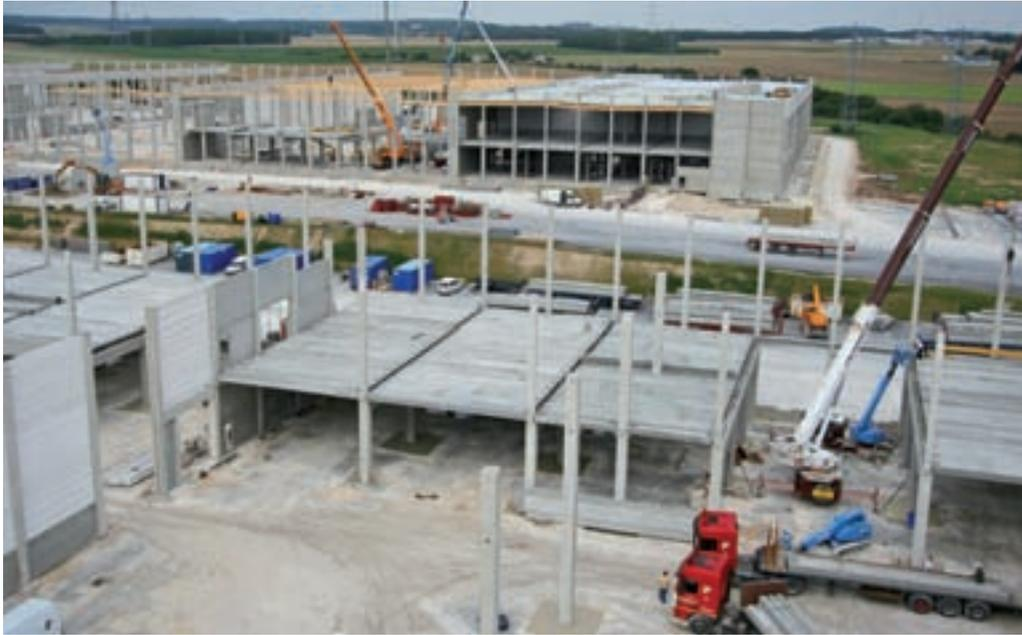
Si des poutres en lamellé-collé ont été mises en place, les poteaux de charpente et les planchers des mezzanines ont été réalisés en béton pour des raisons de stabilité au feu et de charges d'exploitation. Les murs coupe-feu entre cellules, les séparatifs entrepôts-bureaux et les écrans thermiques ont été réalisés en panneaux béton et béton cellulaire pour leur tenue au feu.
