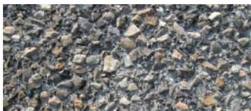
**Le béton désactivé** consiste à pulvériser, à sa surface, un produit retardateur qui, une fois la prise effectuée, permettra à l'aide d'un puissant jet d'eau, de faire apparaître le granulat.
