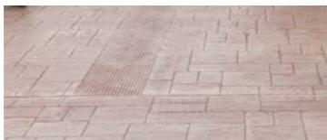
**Le béton dit « imprimé »** est moulé au moment du coulage de la dalle. Ce moulage permet des combinaisons infinies de formes, de couleurs, de textures, et peut prendre au choix l'apparence de la pierre naturelle, du pavé de granit, du grès...
