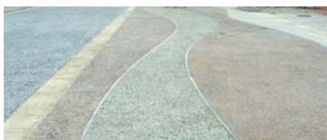
**Le béton coloré** dont la teinte dépend de celles du ciment et des granulats qui le composent, est obtenu par l'incorporation de pigments naturels lors de sa fabrication en centrale.
