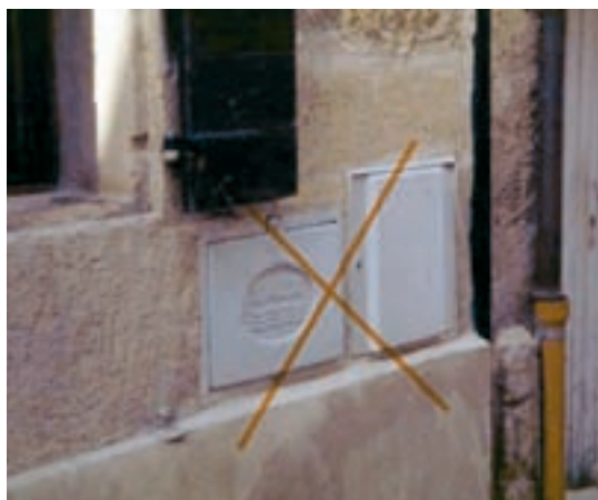
Fig. 41 - A éviter : coffrets encastrés dans les murs et trumeaux participant au contreventement
