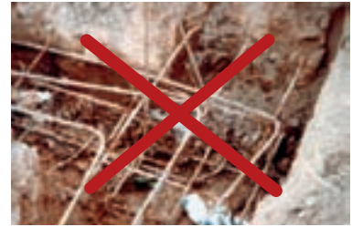
Fig. 74 - Absence de béton de propreté: à proscrire
