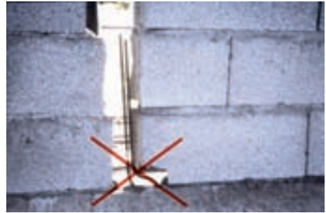
Fig. 52 - A éviter : armatures de chaînage vertical déviées
