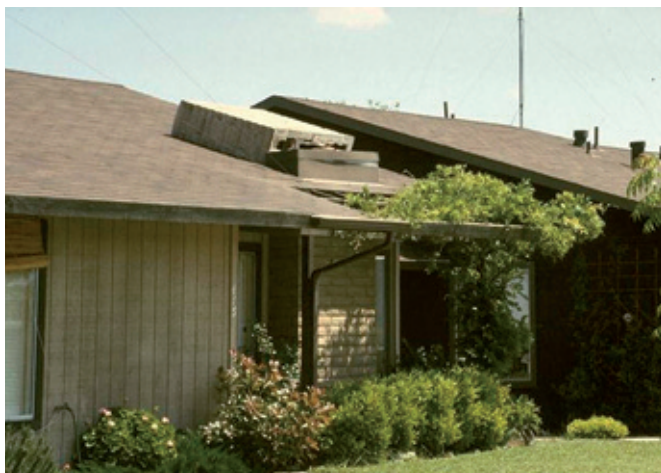
Fig. 100 - Effondrement de souches de cheminée élancées
