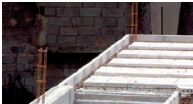
Fig. 51 - Armatures des chaînages verticaux en attente de recouvrement, longueur 60 Ø
