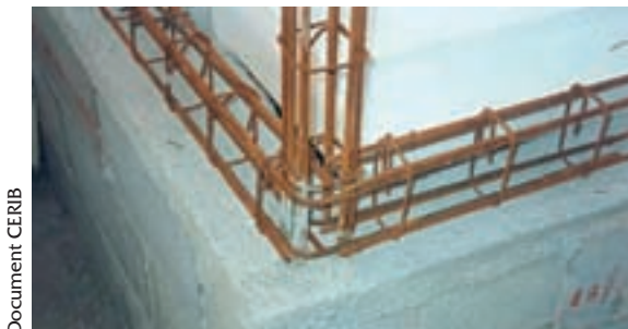
Fig. 54 - Mise en place de boucles de continuité
