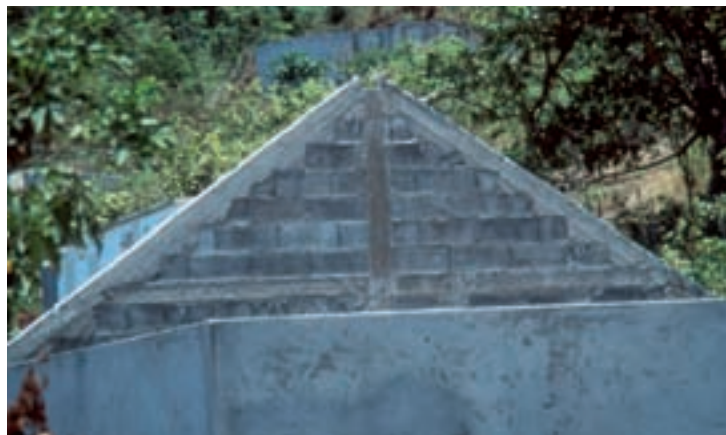
Fig. 63 - Les assises du chaînage de couronnement devraient être horizontales (sous-face en dents de scie)
