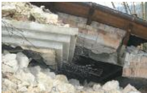
Fig. 13 - Effondrement d'une construction en maçonnerie non parasismique, séisme de L'Aquila, Italie 2009
