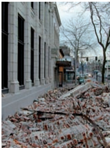
Fig. 106 - Chute d'acrotères en maçonnerie non chaînée
