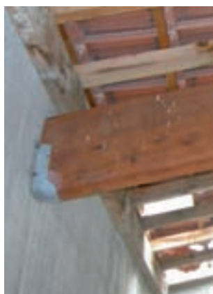
Fig. 65 - Chevron et ferme fixés par l'intermédiaire d'un sabot métallique : solution correcte
