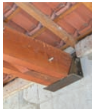
Fig. 65 - Chevron et ferme fixés par l'intermédiaire d'un sabot métallique : solution correcte
