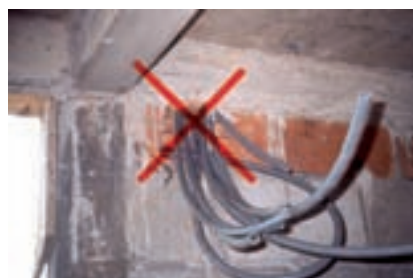
Fig. 66 - Gaines placées dans les chaînages : à proscrire
