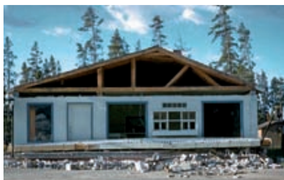
Fig. 95 - Effondrement d'un mur pignon en maçonnerie non solidaire de la charpente
