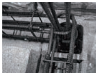
Fig. 54 - Mise en place de boucles de continuité
