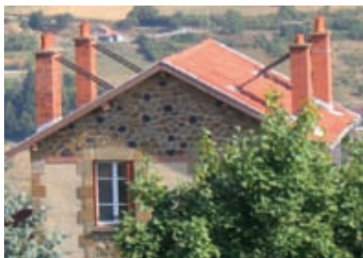
Fig. 104 - Exemple de souches haubanées
