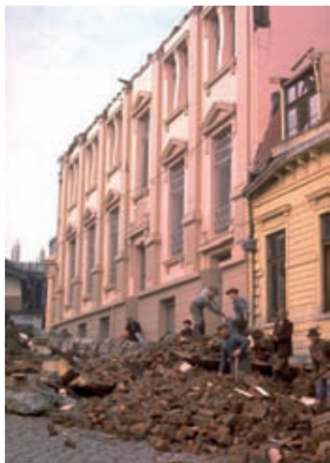
Fig. 106 - Chute d'acrotères en maçonnerie non chaînée
