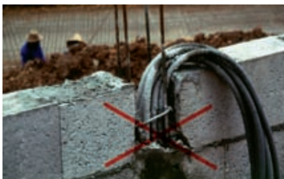
Fig. 66 - Gaines placées dans les chaînages : à proscrire
