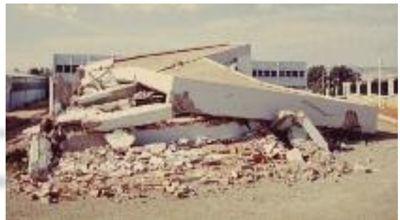
Fig. 17 - Effondrement de constructions exposées à une torsion
