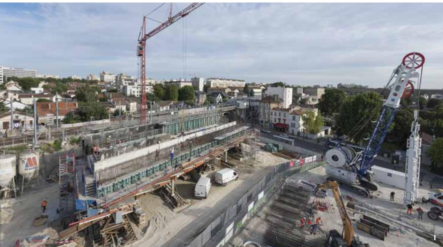
G, H ___ Pont-dalle à Arcueil - Cachan. Après le coulage et quelques jours avant le ripage.
