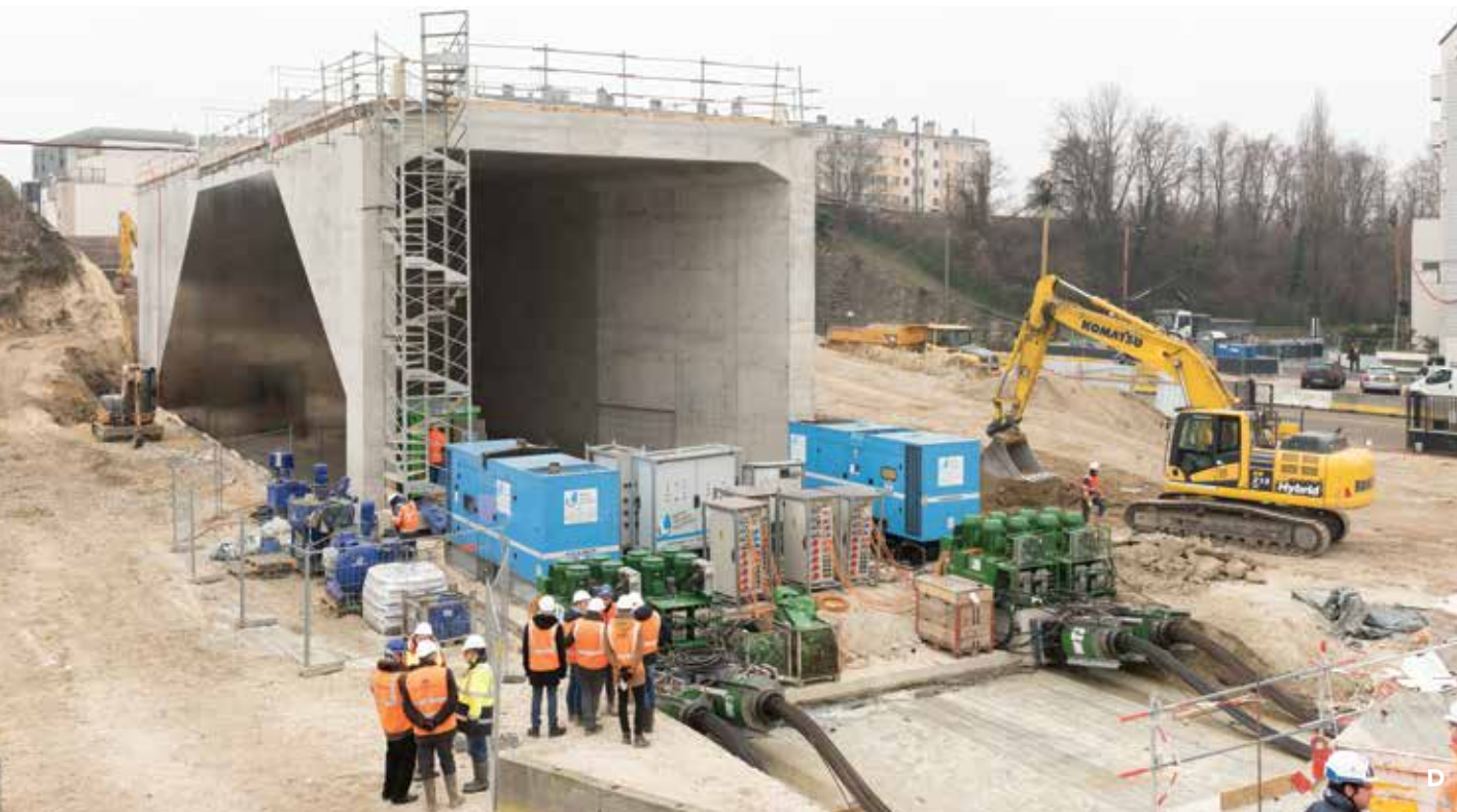
B Ripage de la dalle de couverture pour la gare Fort d'Issy - Vanves - Clamart.
