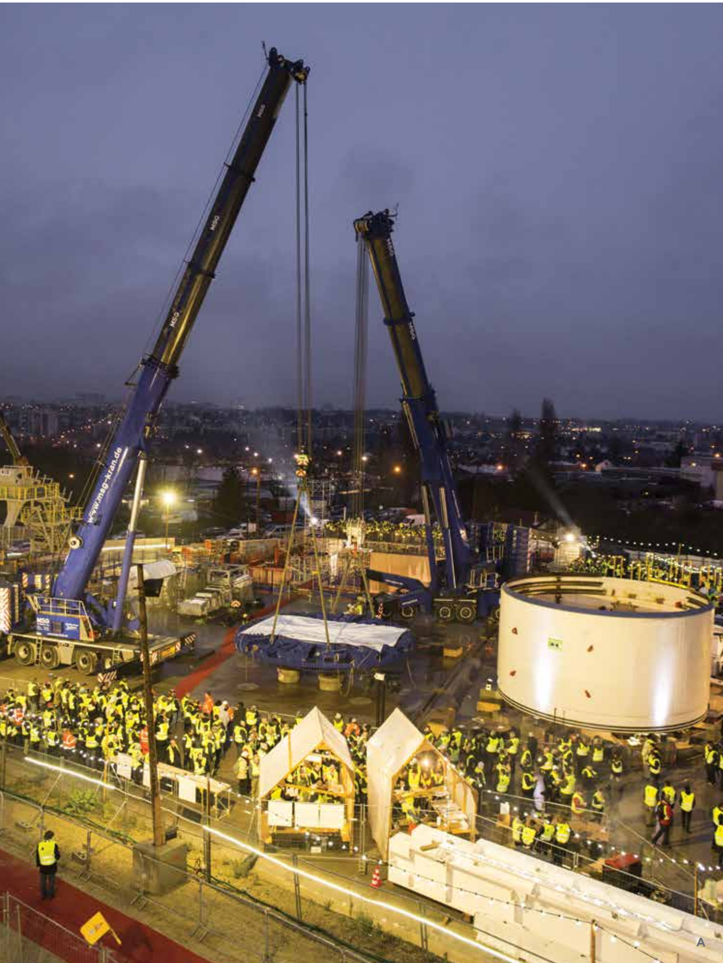
A — Lancement du premier tunnelier du Grand Paris Express à Champigny, février 2018.
