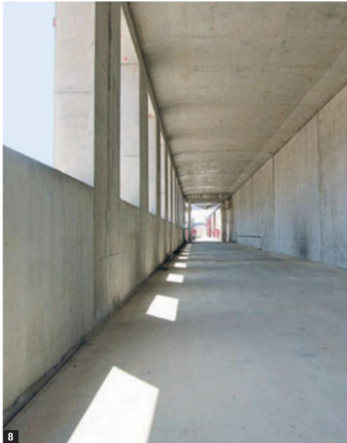
>>> **6** Les murs intérieurs des cadres sont travaillés avec un motif de galets. **7** Le grand saut-de-mouton a une longueur de 234 m. **8** L'effet de piston engendré dans le saut-de-mouton est neutralisé par de grandes ouvertures.
