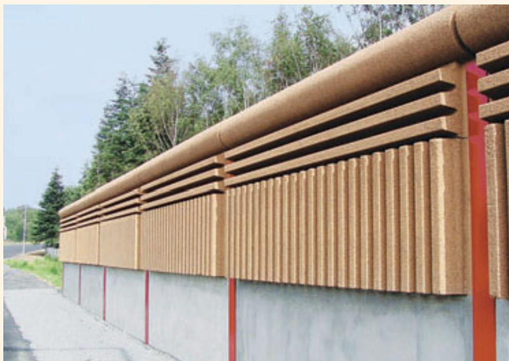
2005 sur 800 m. Une seconde de 1 200 m s'est achevée fin juillet 2006. Les avantages de ce dispositif ? Avec la réduction du nombre de joints horizontaux par rapport à l'élément de base, l'étanchéité sonore est améliorée d'où, d'une part, une meilleure performance acoustique de l'écran et, d'autre part, une réduction des coûts d'entretien au niveau des joints. "Les trames sont fabriquées en usine, donc dans de bonnes conditions. Lorsqu'elles
