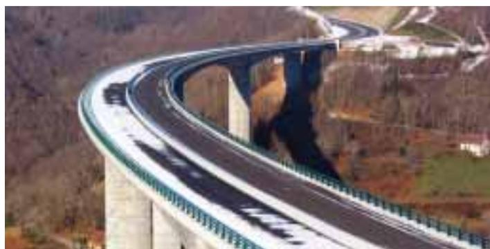
**>>> La double courbure de l'ouvrage a exigé un contrôle renforcé des systèmes de visée et de guidage des équipages mobiles de construction par encorbellement.**
