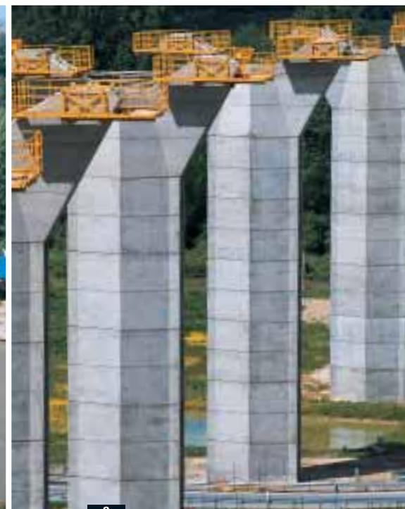
>>> **1** Vingt et une piles en béton armé, toutes identiques, supportent le tablier mixte du viaduc. **2** Les piles les plus hautes atteignent 37,20 m, les plus courtes, 15,80 m.
