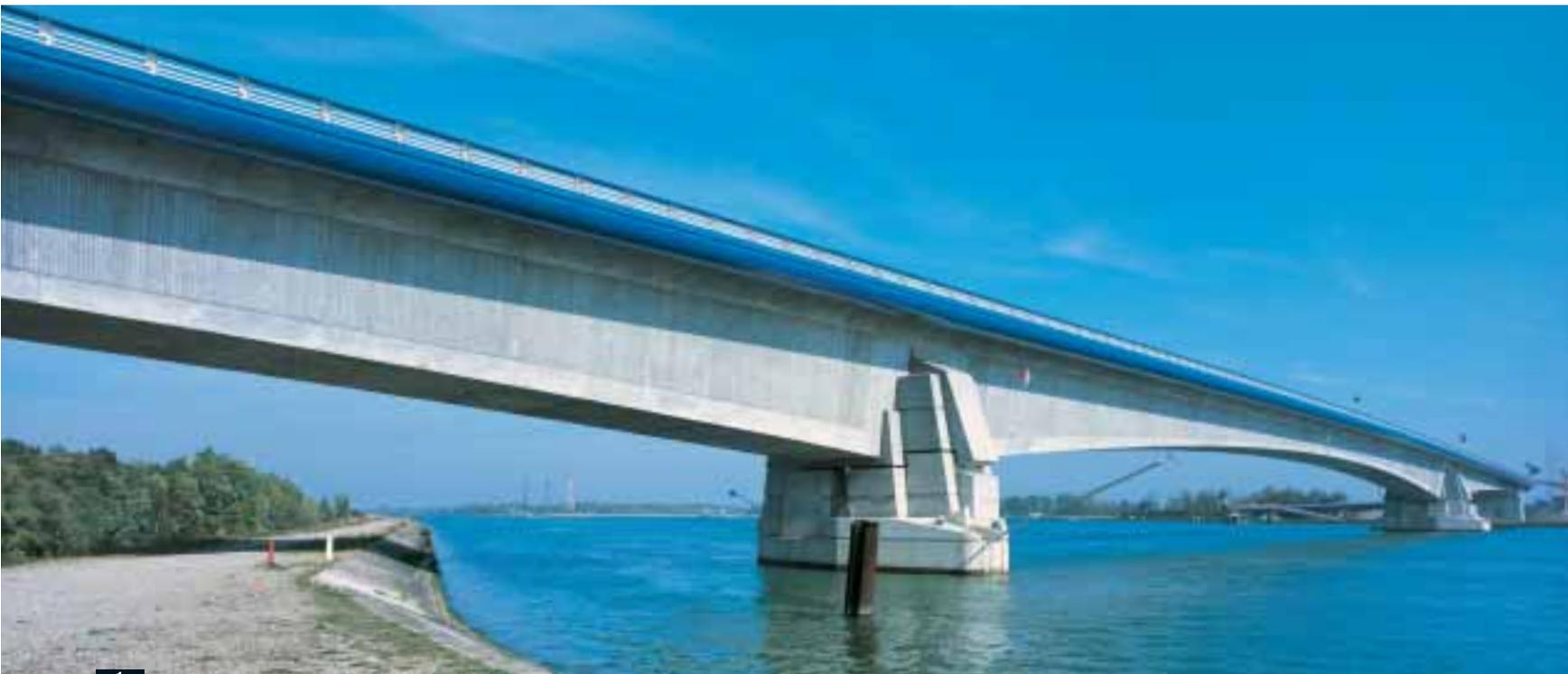
>>> **1** Au niveau du chenal navigable, le pont offre un tirant d'air de 7 m de haut sur 175 des 205 m de la travée centrale.
