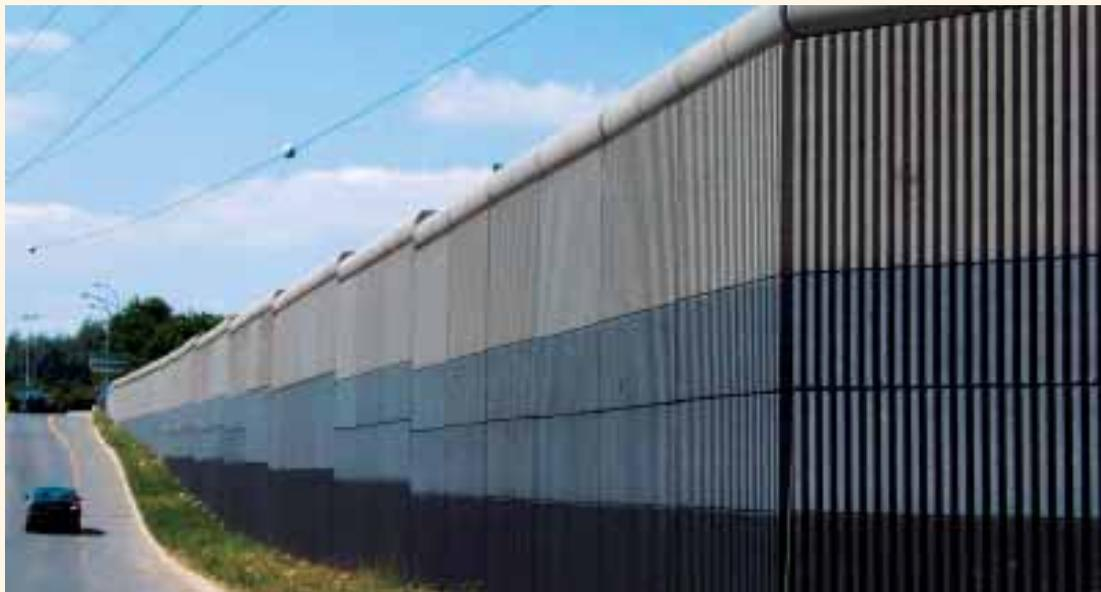
qui permet un recouvrement des poteaux métalliques et les rend invisibles. Cette approche technique augmente le rendement acoustique de l'écran tout en protégeant la structure métallique.
