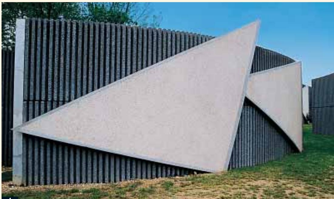
acquise de longue date de par l'utilisation même du béton. L'insensibilité de ces ouvrages de génie civil au vent, à la pluie, aux agents corrosifs dus à la pollution, confirme cette tenue dans le temps tout en garantissant les caractéristiques acoustiques obtenues au départ.
