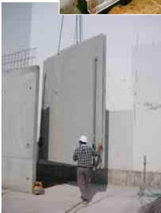
Les murs à coffrage intégré sont des éléments structuraux préfabriqués constitués de deux peaux en béton, reliées par des connecteurs, et d'un vide central destiné, après mise en place des armatures, à être rempli de béton sur chantier.
