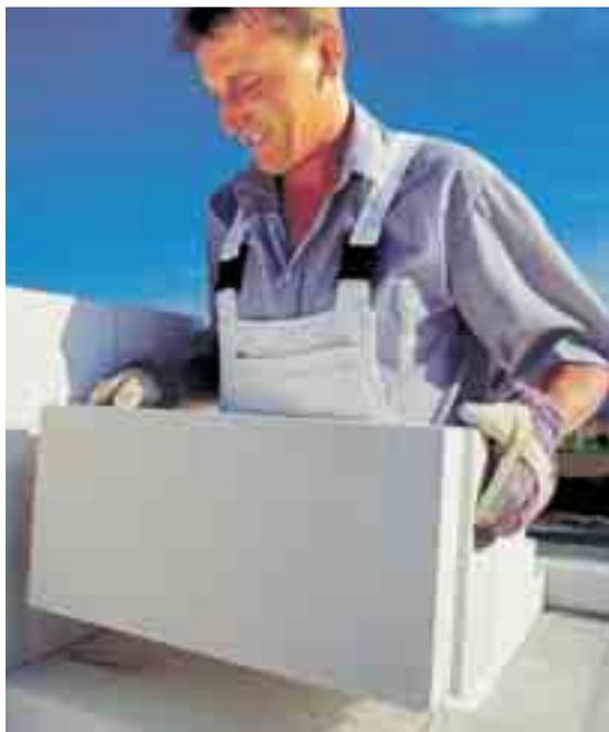
Les blocs de granulats isolants ou en béton cellulaire relèvent également de la norme NF EN 771 (parties 3 et 4 dans le cas du béton cellulaire). L'intérêt principal de ce type de blocs tient en ce qu'ils possèdent des **caractéristiques thermiques** nettement supérieures aux blocs de granulats courants. Par contre, leur résistance à la compression, plus faible, limite leur utilisation pour des bâtiments de plusieurs niveaux.
