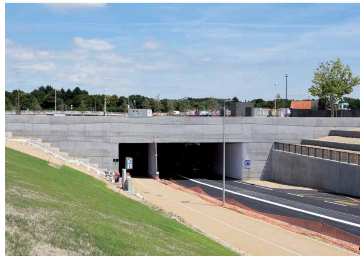
Sur un volume total de béton atteignant les 17 500 m<sup>3</sup>, celui mis en œuvre pour la structure des voiles et de la traverse supérieure présente une formulation complexe. À noter, en façade, les reliefs en « décrochement » évoquant les vagues.
