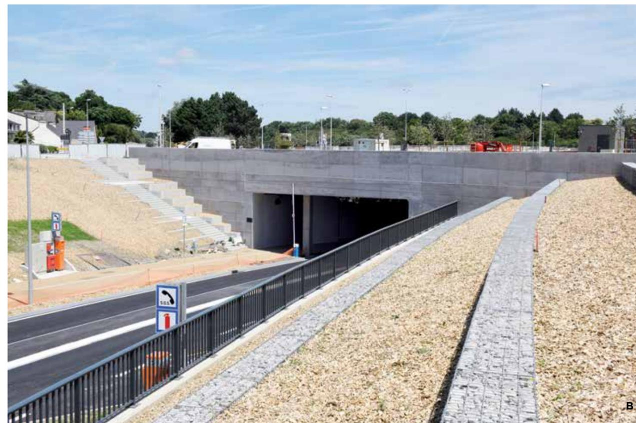
A — Le tunnel est situé à une cinquantaine de mètres en aval du pont de Kérino. Pour conserver en permanence un accès à l'avant-port, sa réalisation, à l'abri de batardeaux, a été menée en plusieurs phases.
