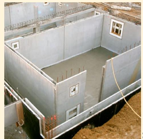
>>> Figure 14. Construction réalisée par prémurs.
