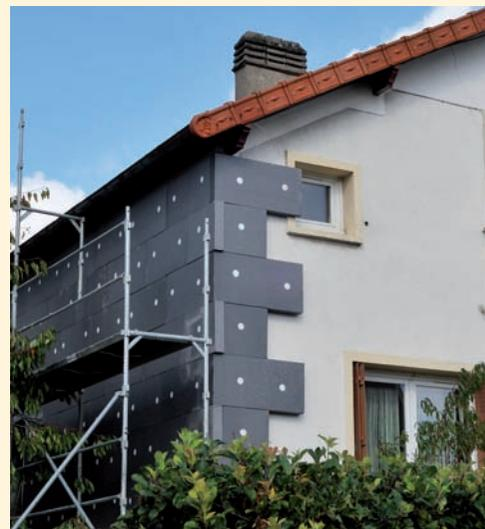
>>> Figure 9. Isolation thermique par l'extérieur appliquée en réhabilitation d'une maison individuelle. Isolant en cours de pose.
