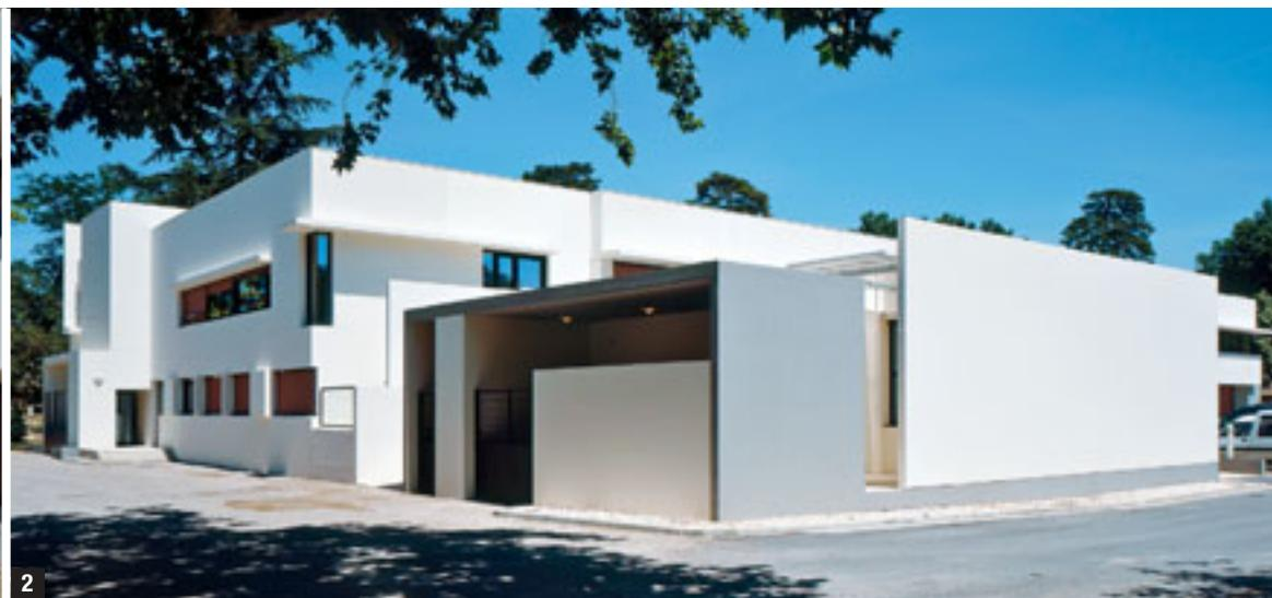
>>> **1** Au sud, les dispositifs architecturaux protègent les baies vitrées du soleil d'été pour éviter les surchauffes et favoriser le confort thermique. L'hiver, le soleil plus bas chauffe naturellement les locaux. **2** Le pignon ouest est caractérisé par ses cadres de béton qui permettent de masquer les édicules techniques (local à poubelles et cour de service).
