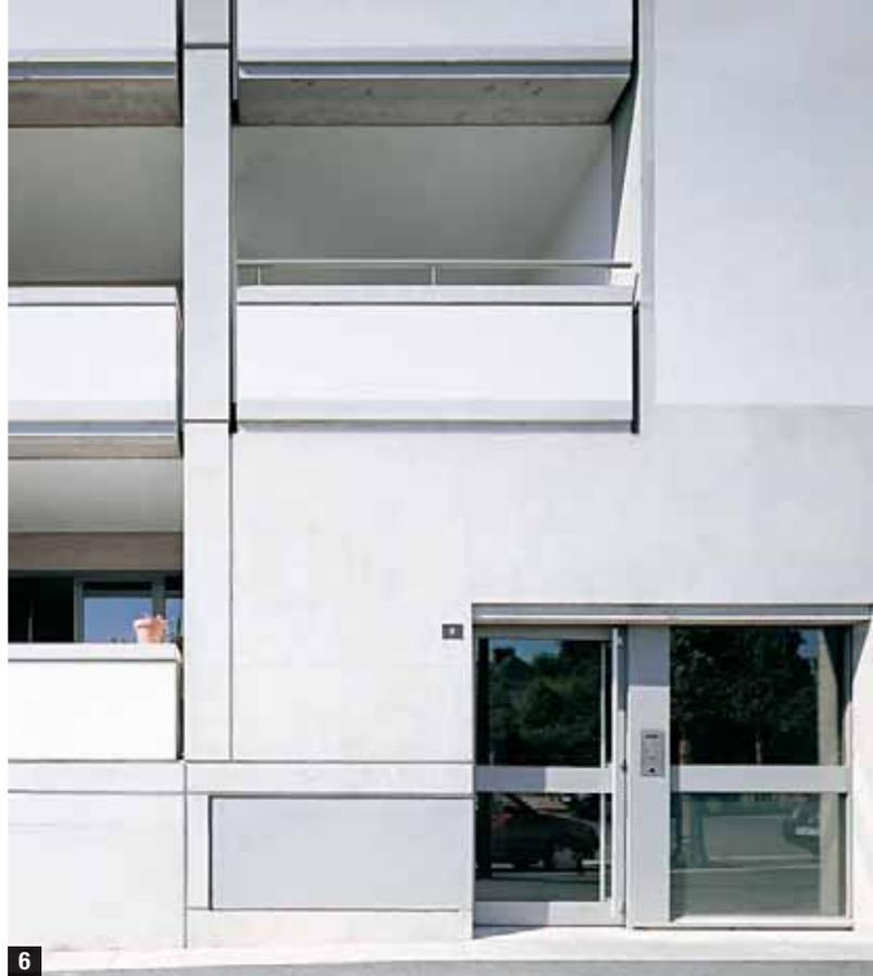
>>> **5** L'immeuble de logements s'insère dans un vaste programme d'aménagement en plusieurs tranches d'un îlot du centre-ville. **6** L'ensemble est réalisé en béton coulé en place, excepté les garde-corps des balcons, réalisés en béton préfabriqué.
