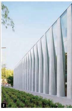
>>> 1 La pierre sèche de l'ancienne gare de tramway, réutilisée sur le mur de clôture, révèle l'aspect lisse et brillant du béton banché du gymnase. 2 La façade Nord est caractérisée par une succession de piles qui dessinent une véritable colonnade de béton affinée par la pose biaise des travées de verre.
