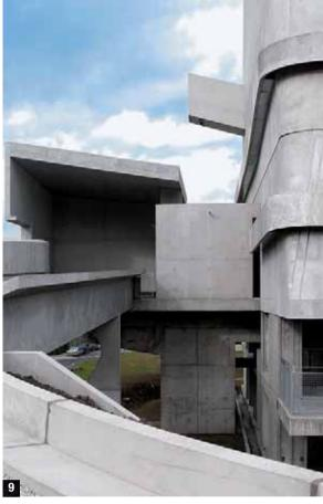
qualité de finition, et nécessitait un temps de durcissement de 48 heures avant décoffrage. Des joints parfaitement étanches ont été réalisés entre les coffrages pour éviter toute fuite de laitance. L'épaisseur des murs varie, selon les façades, de 21,5 cm pour le mur vertical à 24,5 cm pour la façade est, et 23,7 cm pour les murs sud et nord.
