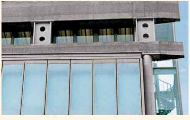
seulement par les failles de lumière. Plus classique en apparence, cette façade laisse apparaître l'étonnante structure du bâtiment, où l'essentiel des charges des six niveaux de superstructure sont reprises par le plancher du premier étage, le plancher haut du rez-de-chaussée étant lui-même suspendu à celui du premier niveau.
