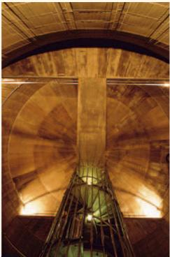
Chavagnes-les-Eaux – C'est la reprise et l'inversion du socle des moulins à vent qui ont donné sa forme au château d'eau. La ligne discontinue de l'acrotère vient couronner l'ouvrage. Comme l'extérieur, l'intérieur bénéficie d'une mise en lumière qui révèle la mise en œuvre du béton. Laval – Implanté dans un contexte urbain, le château d'eau de Laval reprend, dans une version plus élancée, celui de Chavagnes-les-Eaux.
