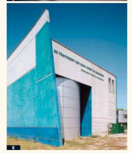
Cantinolle – Les quatre cuves de désodorisation en polypropylène bleu s'affichent à l'abri d'une paroi de verre. L'entrée de la station est cadrée par deux bâtiments en béton brut Sabarèges – Une échancrure dans le voile de béton met à jour le cylindre d'une des étapes du process. Une lasure bleue marque la hauteur de l'eau.
