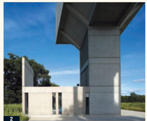
>>> **1** La cuve horizontale se colore de bleu grâce aux projecteurs installés en périphérie. **2** D'étroites baies verticales de plancher à plancher permettent un éclairage naturel des locaux techniques.
