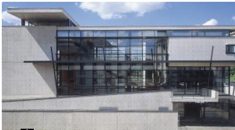
>>> **1** Une grille régulatrice très précise orchestre le jeu des parois pleines et des surfaces vitrées. **2** Une rampe à 5 % permet de relier les deux niveaux de la place et les deux niveaux d'accès à la médiathèque. De par leur transparence, ces entrées sont aisément identifiables par le piéton.
