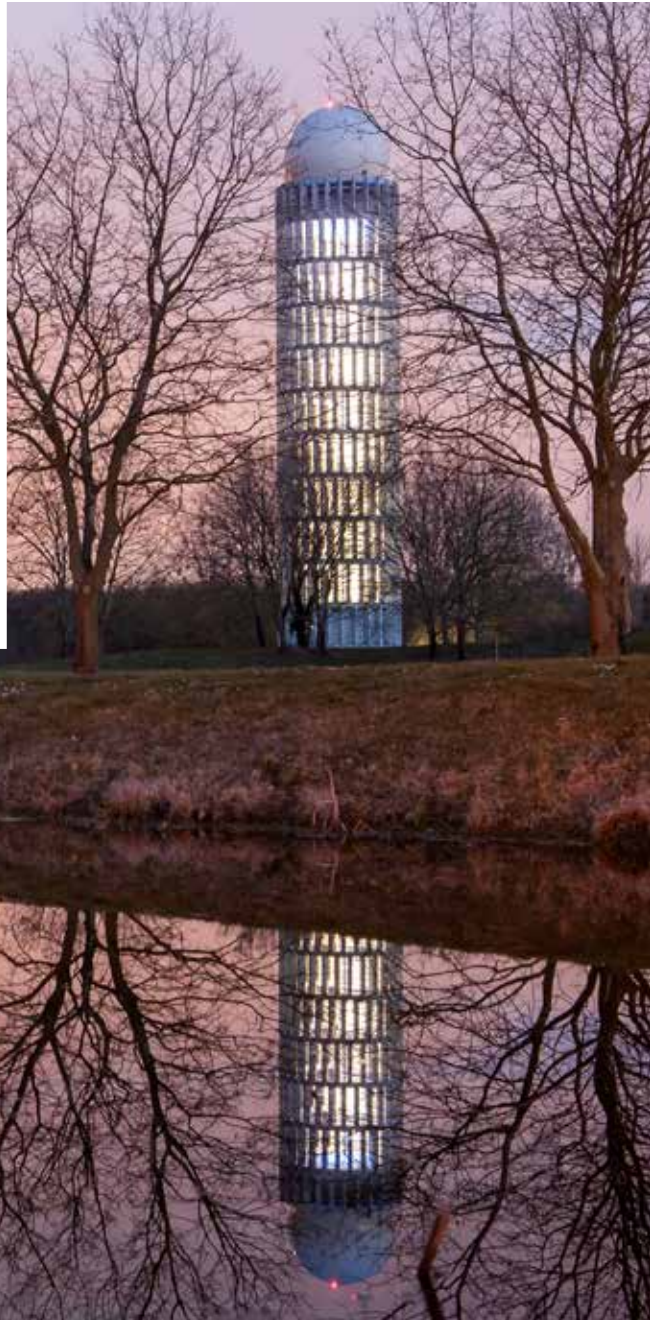
PAGE 21 : Vue de la tour en cours de montage depuis la grue. PAGE 22 : Vue de l'édifice livré, de jour et à la tombée de la nuit.
