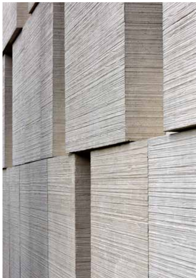
PAGE 24 : En haut : Les panneaux en béton préfabriqué lisses contrastent avec le paysage méditerranéen recréé dans le patio intérieur. En bas : Les panneaux de parement de la façade sont réalisés avec des retours suffisamment épais pour bien exprimer la masse.
