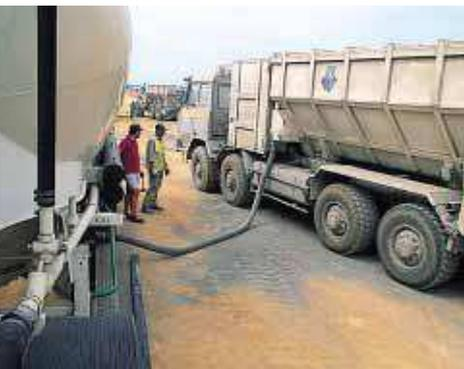
▲ Le liant hydraulique routier acheminé par citernes sur le chantier, est transféré dans la benne de l'épandeur au moyen d'une pompe.
