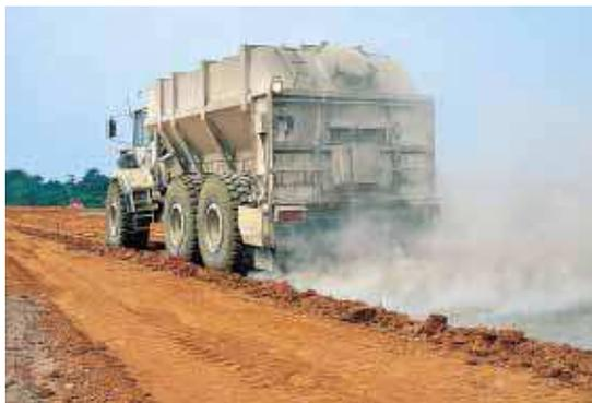
▲ La quantité de liant épanchée sur le sable est dosée à raison de 5 % du poids du matériau à traiter, soit 40 kg. Deux phases sont nécessaires.
