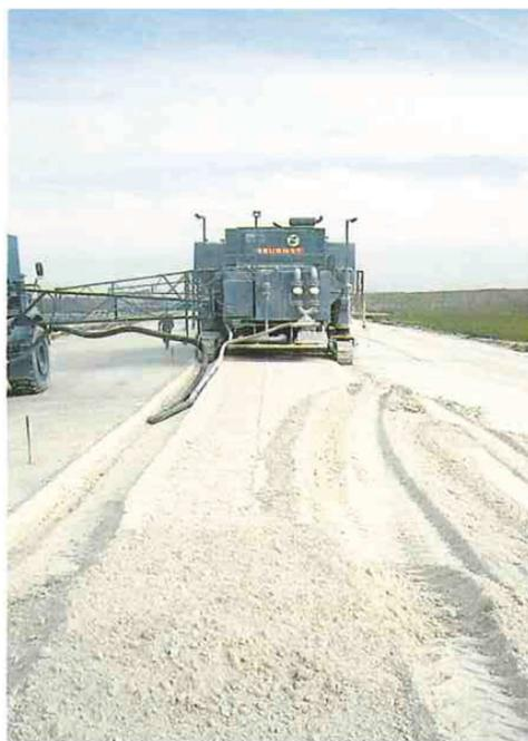
◀ A l'arrière de la deuxième machine, à gauche, l'apport d'eau par serpent hypnotisé.
