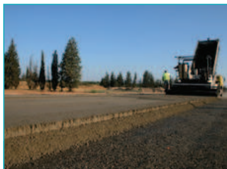
Réalisation de la seconde passe du béton compacté routier.
