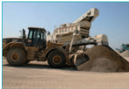
Le concassage des matériaux est effectué sur site.
