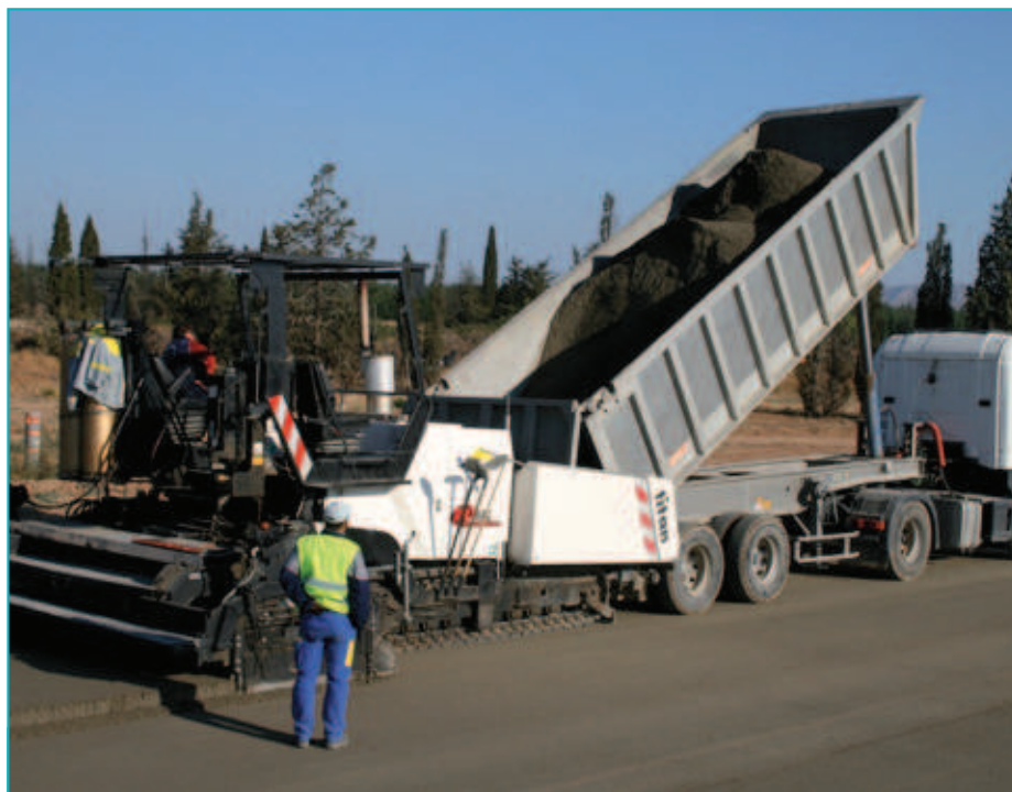
L'atelier de réalisation du béton compacté routier.
