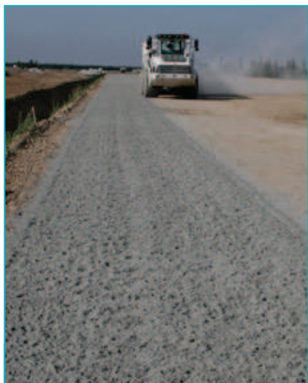
Épandage du liant hydraulique routier avant le traitement de la couche de forme.
