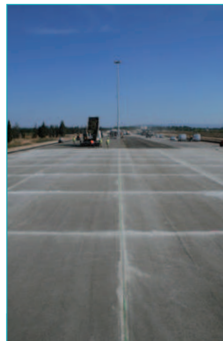
En tout : 16 km de linéaires à scier pour réaliser les joints de retrait.
