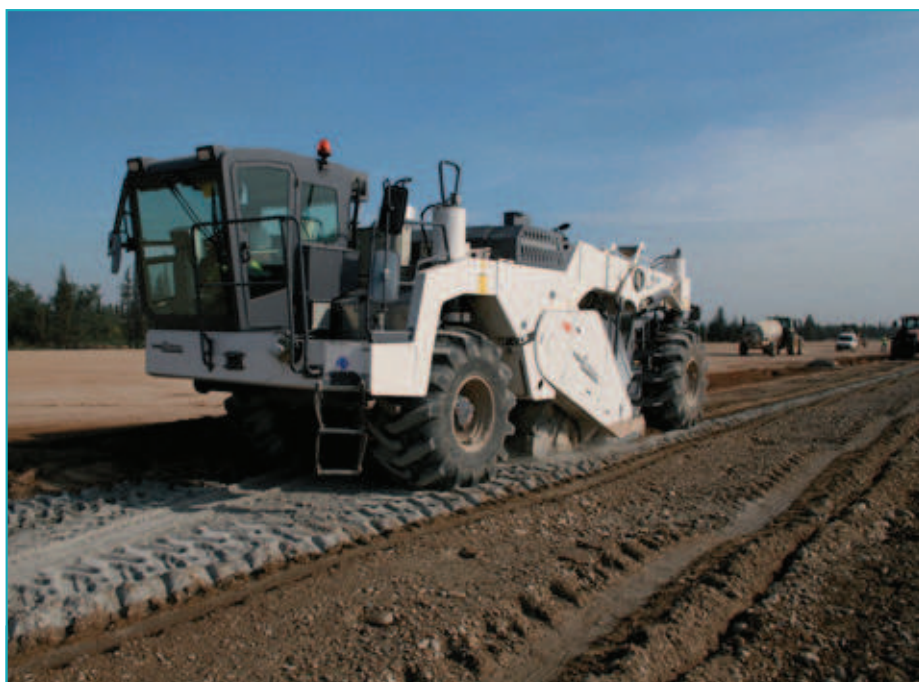
Phase de malaxage pour la réalisation de la couche de forme traitée.
