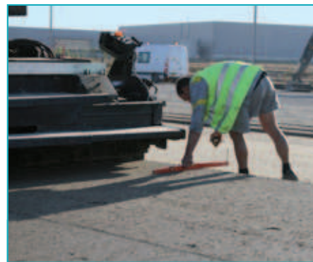
Vérification de l'épaisseur du béton compacté routier.
