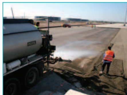
Application du produit de cure par pulvérisation d'émulsion de bitume.
