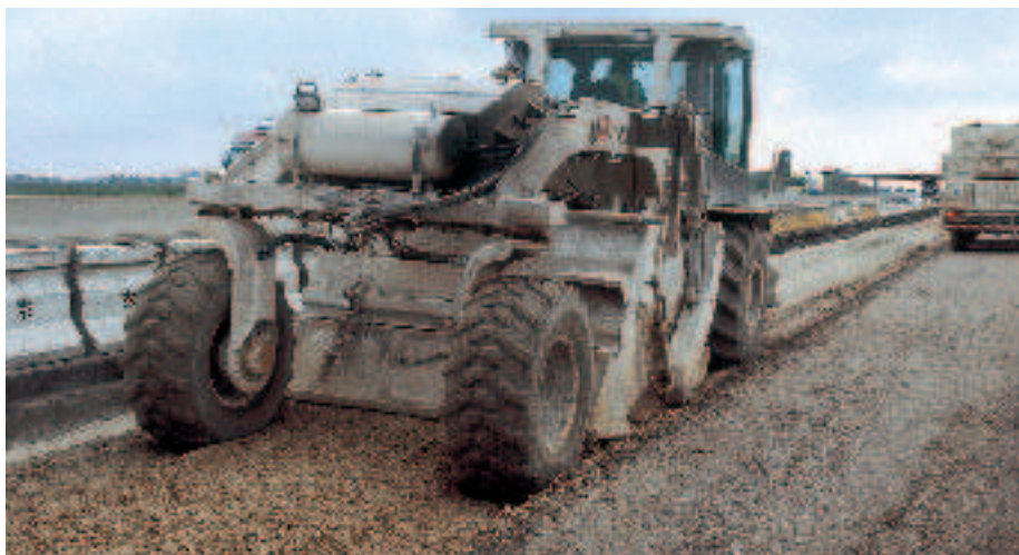
Le malaxeur mélange intimement les matériaux en place au liant hydraulique routier (et à la chaux, si nécessaire) pour réaliser la couche de forme de la nouvelle voie lente.
