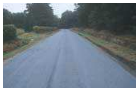
Un enduit gravillonné est ensuite appliqué sur la chaussée.
