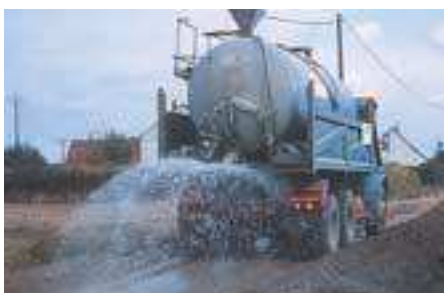
La structure est arrosée pour corriger la teneur en eau avant le malaxage final.
