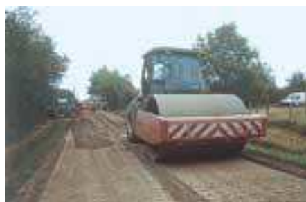
Profil définitif de la chaussée en double pente après nivelage et compactage.
