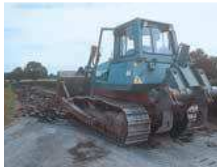
La chaussée existante est déroctée par ripage avec un bulldozer.
