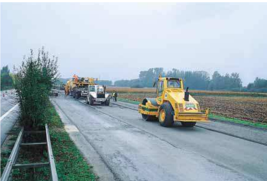
▲ Le passage des compacteurs termine la mise en œuvre des matériaux recyclés en place.
