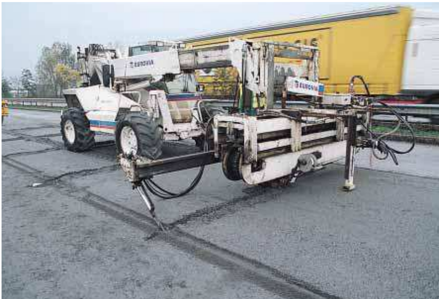
▲ Fixée à l'avant d'une poutre télescopique, la machine Olivia crée une fissure fine tous les 3 m en insérant dans le matériau retraité frais un ruban plastique.
