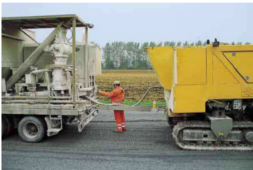
▲ Ajouté au matériau fraisé, le mélange liant hydraulique routier/eau permet d'obtenir in situ la nouvelle grave hydraulique.
