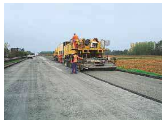
▲ Large de 10 m, la chaussée est retraitée en trois bandes successives.
