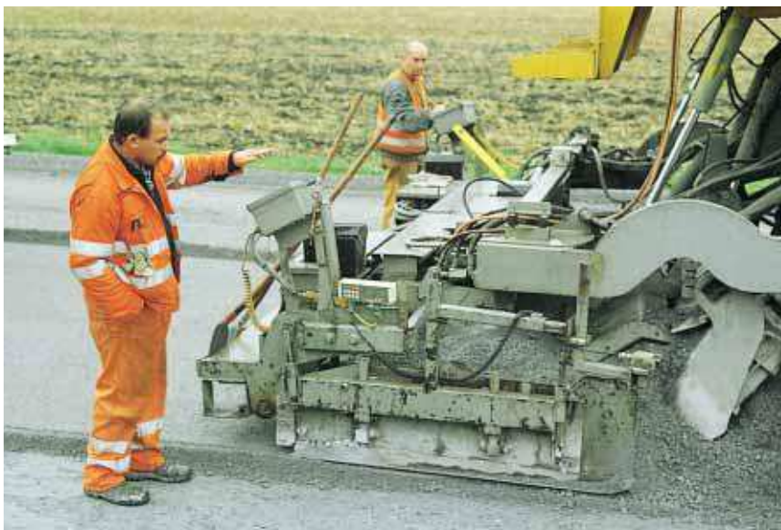
▲ La fraiseuse commence par décohesionner l'ancienne assise de chaussée en graves-cendres volantes sur 25 cm d'épaisseur.
