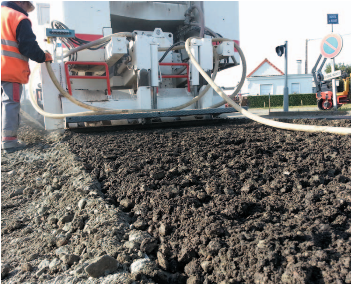
L'ARC® 1000 vu de l'arrière, avec le mélange homogène résultant du broyage de l'ancienne chaussée préalablement scarifiée.
