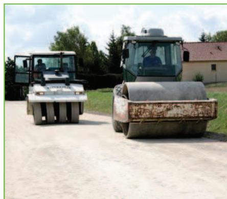
Origny-le-Sec (Aube) : deux compacteurs (à pneus et vibrant) assurent la régularité de la future chaussée.
