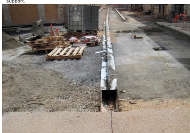
Rue de la République. Fondation en grave-bitume épaulant le caniveau à fente.
