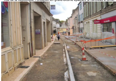
Rue de la République. Mise en œuvre manuelle du béton sur les trottoirs. Tiré à la règle sans vibration, le béton doit présenter une consistance
