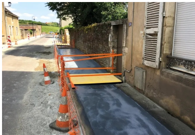
Rue de Beaune. Trottoirs en béton désactivé. À noter les passerelles pour assurer l'accessibilité et la protection du chantier.
