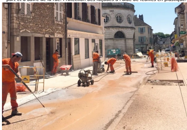
Rue de la République. Voirie en béton désactivé teinté : lavage du béton au jet d'eau à haute pression.
