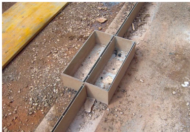
Rue de la République. Mise en place du caniveau à fente sur la plate-forme support.
