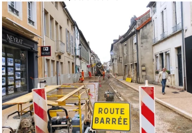
Rue de la République. Aménagement par tranches pour minimiser la gêne aux riverains. Nécessité de travailler par petites zones, en alternant les travaux de part et d'autre de la rue. Protection des façades à l'aide de feuilles en plastique.
