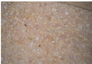
Rue de la République : aire de stationnement en béton bouchardé.
