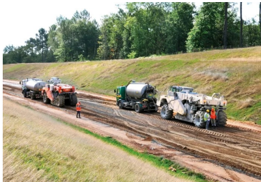
Le traitement a été effectué sur 35 cm de profondeur et 14 m de largeur.
