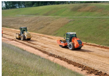
Neuf passes de cylindre vibrant ont été nécessaires pour obtenir la portance souhaitée (T2). Trafic attendu : 200 poids lourds par sens et par jour.
