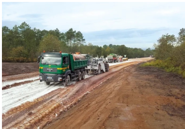
Sur l'emprise de la future voie, les étapes classiques du traitement se succèdent. Le sol ayant été préalablement décapé et mis en forme pour respecter le profil en long, la teneur en eau est vérifiée et éventuellement rectifiée. Puis les deux épandeurs de liants entrent en action, rapidement suivis par les deux malaxeurs agissant en parallèle.
