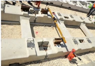
Plate-forme en « ladder track », destinée à accueillir une couverture végétale sur la séquence 1, le long des remparts historiques.
