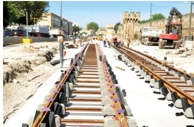
Les rails posés sur des traverses biblocs en béton, préfabriquées par Sateba. En gros plan, à droite, la partie sous patin de l'habillage des rails en mousse polyuréthane. Ces pièces (semelles élastiques) garniront les rails avant le coulage du béton de calage. D'autres pièces viendront garnir les flancs du rail avant le coulage du béton de revêtement.
