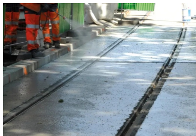
Lavage à haute pression du béton désactivé.
