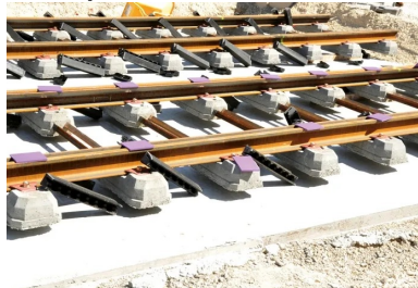
la partie sous patin de l'habillage des rails en mousse polyuréthane. Ces pièces (semelles élastiques) garnissent les rails avant le coulage du béton de calage. D'autres pièces viendront garnir les flancs du rail avant le coulage du béton de revêtement.
