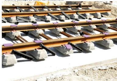
la partie sous patin de l'habillage des rails en mousse polyuréthane. Ces pièces (semelles élastiques) garniront les rails avant le coulage du béton de calage. D'autres pièces viendront garnir les flancs du rail avant le coulage du béton de revêtement.
