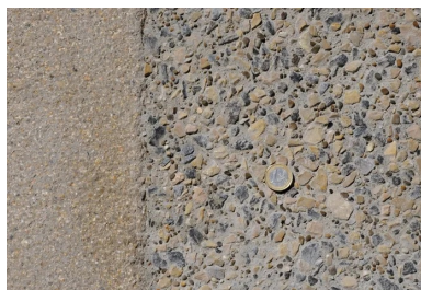
En gros plan, le béton désactivé intégrant deux types de granulats : beige (6/16 SCV à 60 %) et noir (6/16 La Môle à 40 %).
