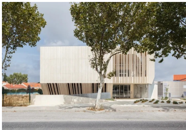
Compte tenu de la taille du terrain et pour préserver devant l'entrée principale un vaste parvis, l'équipement est organisé en hauteur.
