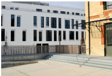
Confectionné à la centrale EQIOM de Nanterre, le béton intègre des granulats de quartz blanc de granulométrie 6/10 avec une adjuvantation spécifique pour béton bouchardé.
