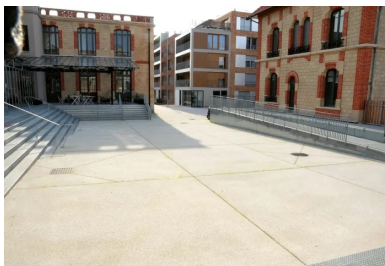
Le revêtement du parvis a été réalisé en Articimo® Bouchardé (PSP 350 kg CE2.5 N CE CP1 NF D10 S3).
