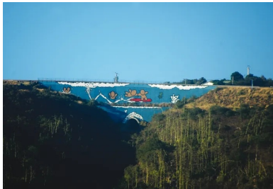
Jace - Mur de soutènement de l'autoroute des Tamarins, Trois Bassins à la Réunion, 2009. [©Jace]
